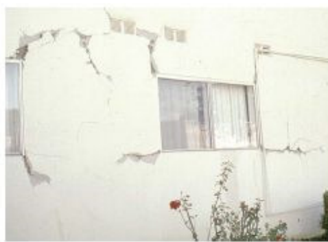
a) Fendilhação diagonal – nembo (Northridge, 1996) b) Flexão - nembos (Northridge, 1996) Figura 8.2 – Mecanismos de rotura observados em paredes de alvenaria (Costa, 2007)
