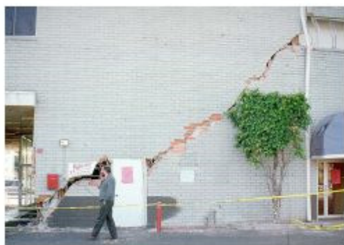
a) Fendilhação diagonal – nembo (Northridge, 1996) b) Flexão - nembos (Northridge, 1996) Figura 8.2 – Mecanismos de rotura observados em paredes de alvenaria (Costa, 2007)
