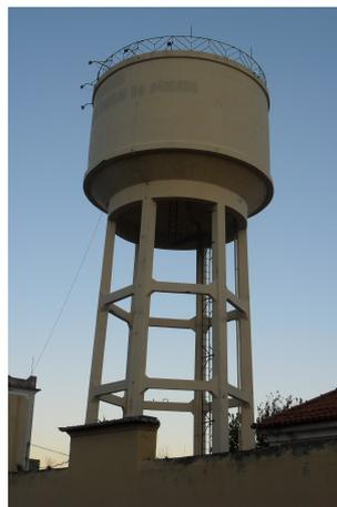
**Figura 3.1** - Reservatório de água do tipo pêndulo invertido na Quinta da Marinha, Vila Franca de Xira.
