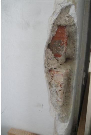
**Figura 3.8 – Parede de tijolo furado**
