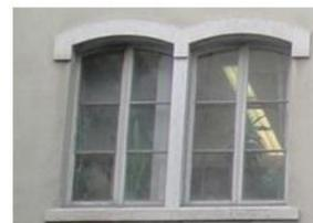
**Figura 6.8 – Pormenor do arco de descarga sobre a janela**
