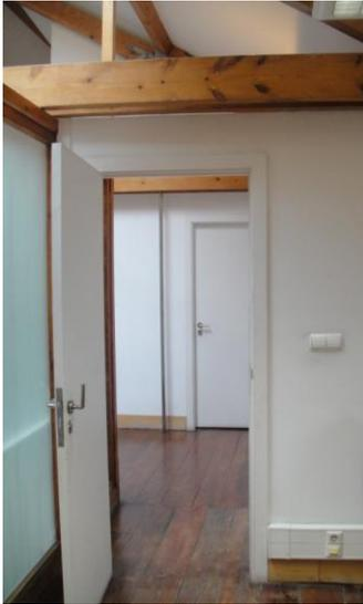
Figura 3.9 – Paredes em *pladur* e divisórias em vidro na Mansarda (Bloco N)
