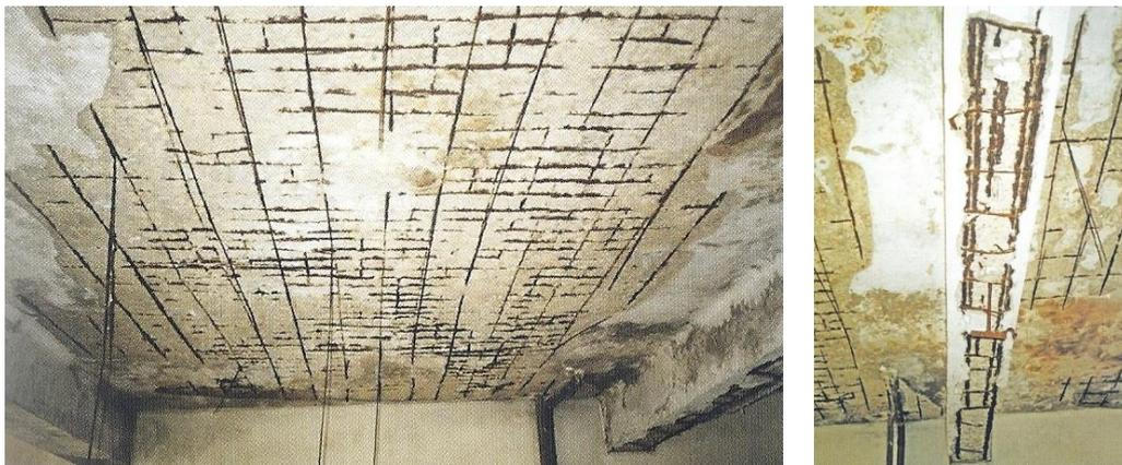
Figura 4.1 - Corrosão da armadura das lajes [Lopes 2008].
