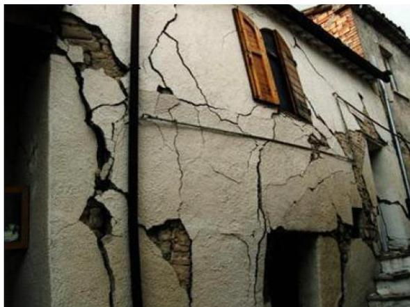
Figura 3.13 - Exemplo de colapso de um edifício por flexão vertical [Borri e De Maria, 2009].
