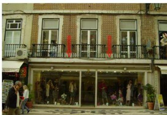
Figura 11 - Exemplo de interrupção de elementos verticais resistentes (Rua Augusta, Arquivo Fotográfico).
