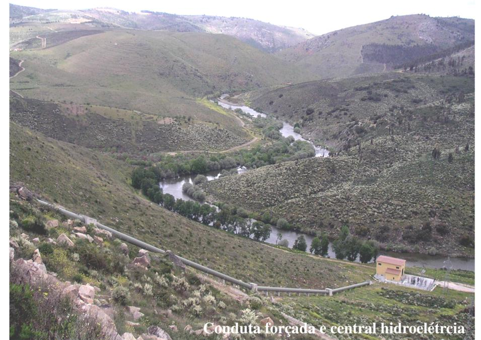
Conduta forçada e central hidroelétrica
