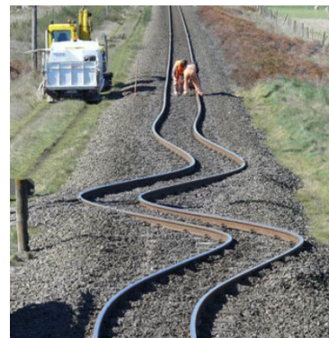
Figura 2.12 – Ruptura de falha (esquerda. Sismo na Turquia, 1999) e falha com movimento na ordem dos 3 metros (direita. Sismo na Nova Zelândia, 2011)
