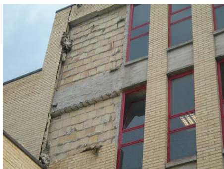
Figura 4.19 – Danos não estruturais no exterior e interior do edifício que inviabilizam sua utilização. Hospital San Salvatore di Coppito
