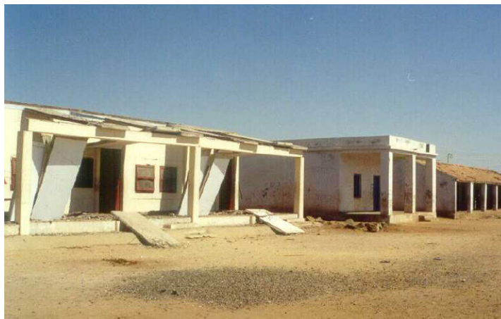
Figura 4.54 – Escola de construção pré-fabricada em Gandhidham
