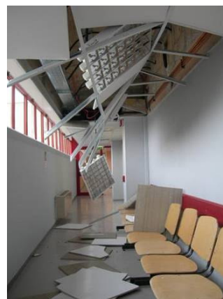
Figura 4.19 – Danos não estruturais no exterior e interior do edifício que inviabilizam sua utilização. Hospital San Salvatore di Coppito
