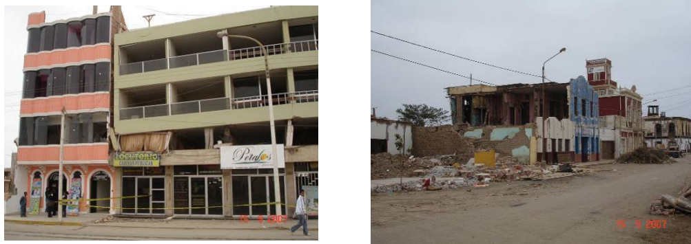
Figura 4.27 – Exemplos de danos em estruturas de betão e alvenaria
