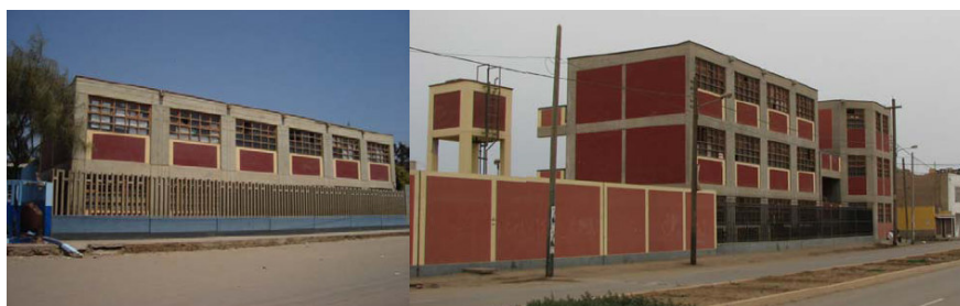
Figura 4.31 – Escola em Pisco sem danos construída de acordo com o Regulamento de 2003
