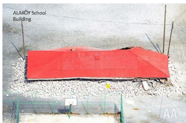
Figura 6.1 – Colapso total de edifício escolar em Alaköy. Sismo 23 de Outubro de 2011, Turquia (M7,2)
