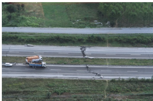
Figura 2.12 – Ruptura de falha (esquerda. Sismo na Turquia, 1999) e falha com movimento na ordem dos 3 metros (direita. Sismo na Nova Zelândia, 2011)
