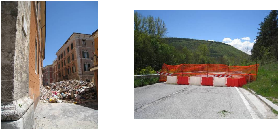
Figura 9.1 – Exemplos de obstrução de vias e acesso interrompido. Sismo de L’Aquila 2009
