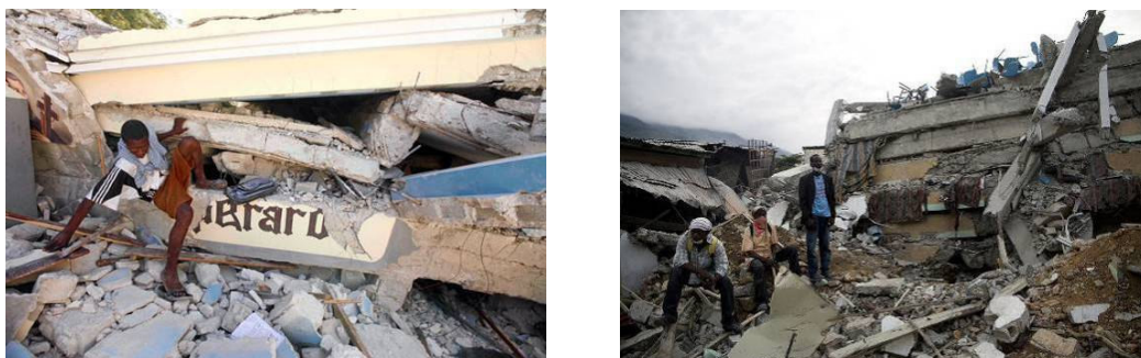
Figura 4.14 – Colapso tipo pancake da Universidade de Saint Gerard onde morreram 200 pessoas
