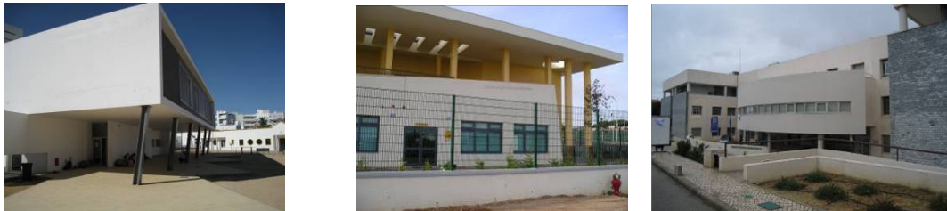
Figura 6.14 – EB1/JI Cavalinha – soft-storey; EB1 de Quarteira – pisos recuados; Universidade do Algarve (Faculdade de Engenharia de Recursos Naturais e Faculdade de Economia) – planta assimétrica
