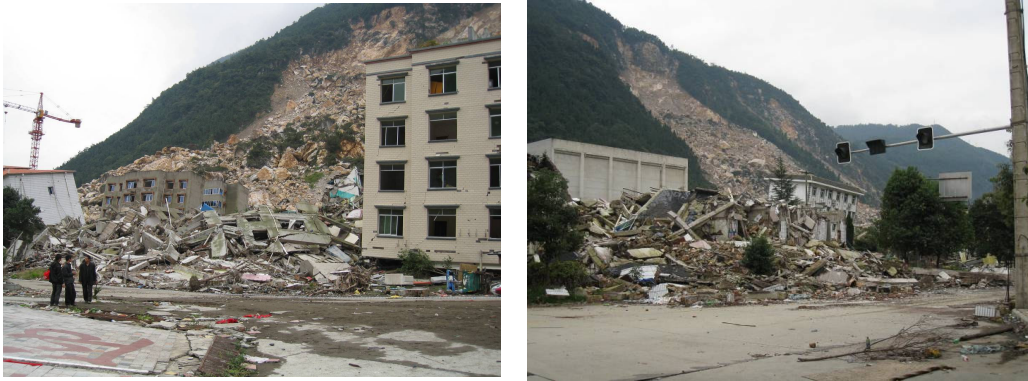
Figura 2.10 – Queda de blocos. Cidade de Beichuan, Sismo de Sichuan, China 2008
