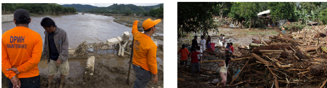
Figura 9.20 – Ponte danificada (esquerda) e escombros (direita) causados pelas inundações trazidas pela tempestade tropical Washi na cidade de Iligan, ilha de Mindanao, Filipinas
