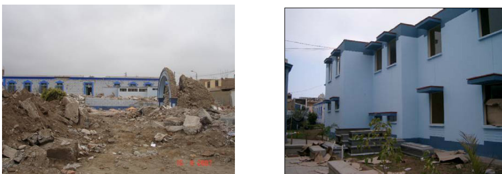
Figura 4.30 – Hospital San Juan de Dios, Pisco. Esquerda: pavilhões antigos, Direita: novo pavilhão projectado segundo os novos requisitos sísmicos de 2003
