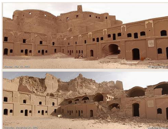
Figura 4.41 – Parte de Arg-e-Bam antes e depois do sismo
