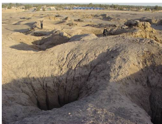
Figura 4.43 – Fenómeno de subsidência com formação de sinkholes devido ao colapso do canal de irrigação Qanat a oeste de Baravat
