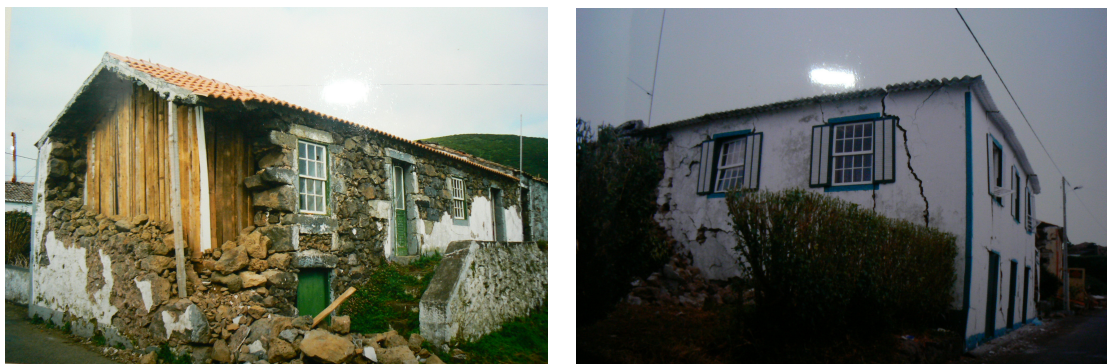
Figura 4.2 – Grau de dano 4 (EMS-98 após o sismo do Faial, 1998)
