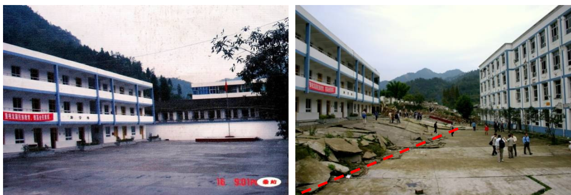
Figura 4.23 – Escola de Bailu com ruptura superficial da falha: antes (esquerda) e depois (direita)
