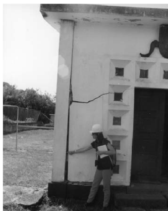
Figura 3: Escola de Espalhafatos. Separação entre a alvenaria e os elementos de betão armado. (Fonte: http://www.oecd.org/dataoecd/43/42/33629167.pdf )
