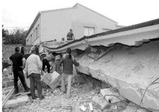
Figura 2: Efeitos do sismo na escola. (Fonte: http://www.poroton.it/user/articoli/n5/crolloscuola.asp )
