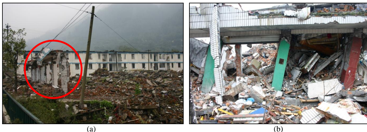
Figura 21: Frontal em betão armado, com colapso da restante estrutura: a) Escola em Hanwang; b) Edifício com “drift” residual (Hanwang)
