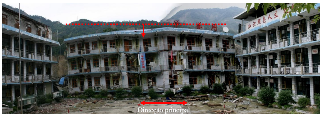
Figura 18: Escola em Beichuan com 3 edifícios semelhantes e colapso de um deles por soft-storey
