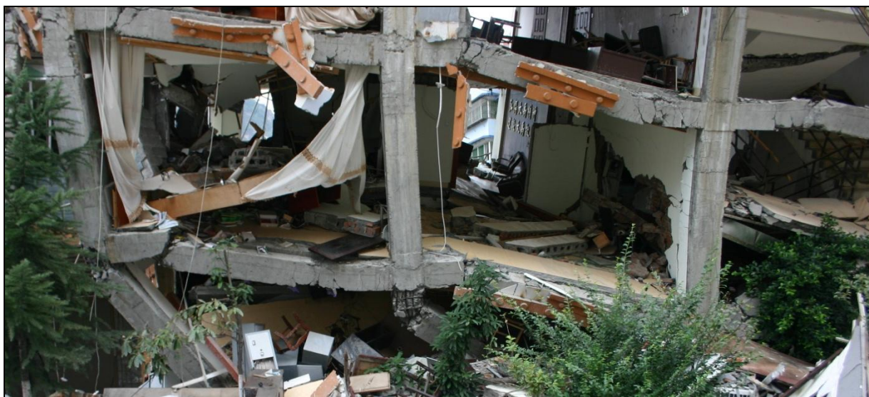
Figura 28: Hotel Beichuan - Comportamento adequado dos nós nos pisos superiores (viga fraca – pilar forte), e ruptura por corte e flexão das vigas. Colapso por soft-storey – Vista de frente
