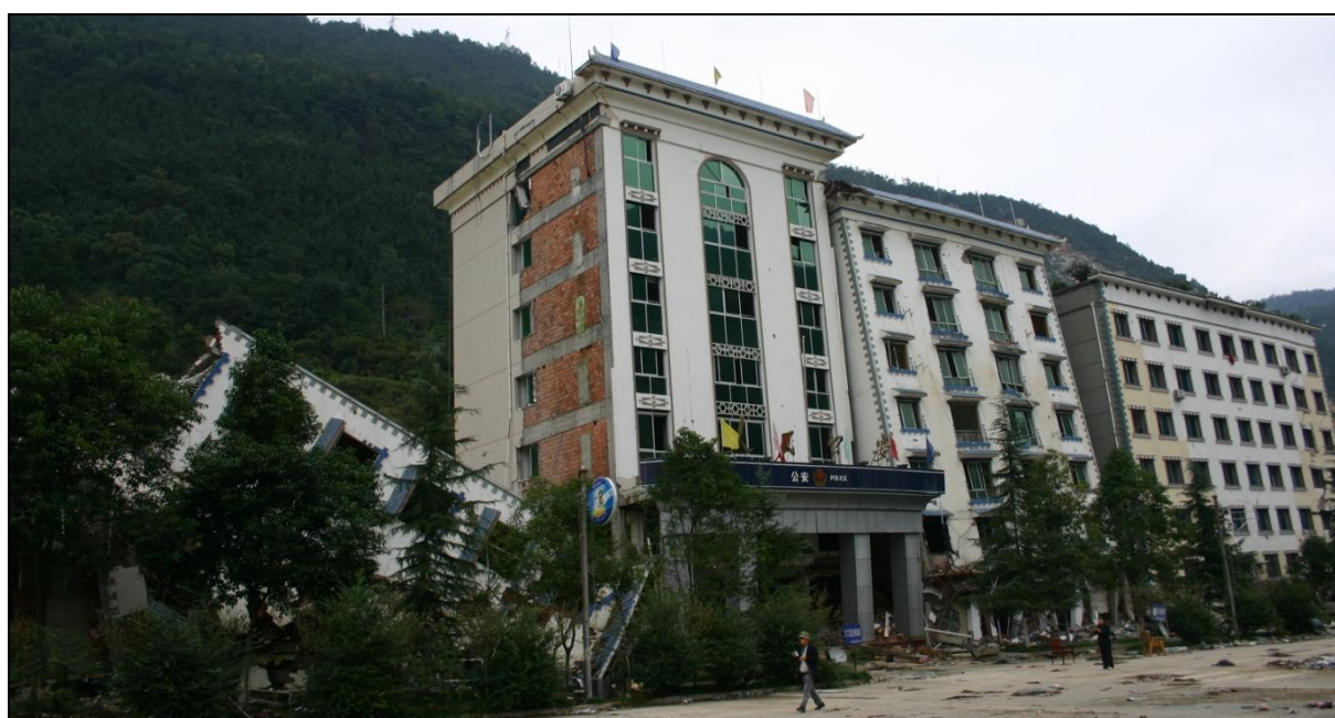
Figura 27: Edifício da Polícia em betão armado, ao lado de edifícios colapsados em alvenaria confinada (Beichuan)
