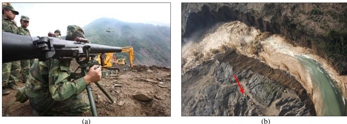
Figura 11: Operações para drenagem do lago: a) utilização de equipamento militar (Fonte: AP Photo/Xinhua/ Li Gang) ; b) abertura do canal de drenagem, com destaque para as dimensões de um “dumper” comparativamente ao canal de drenagem do lago (Fonte: Xinhua Photo).
