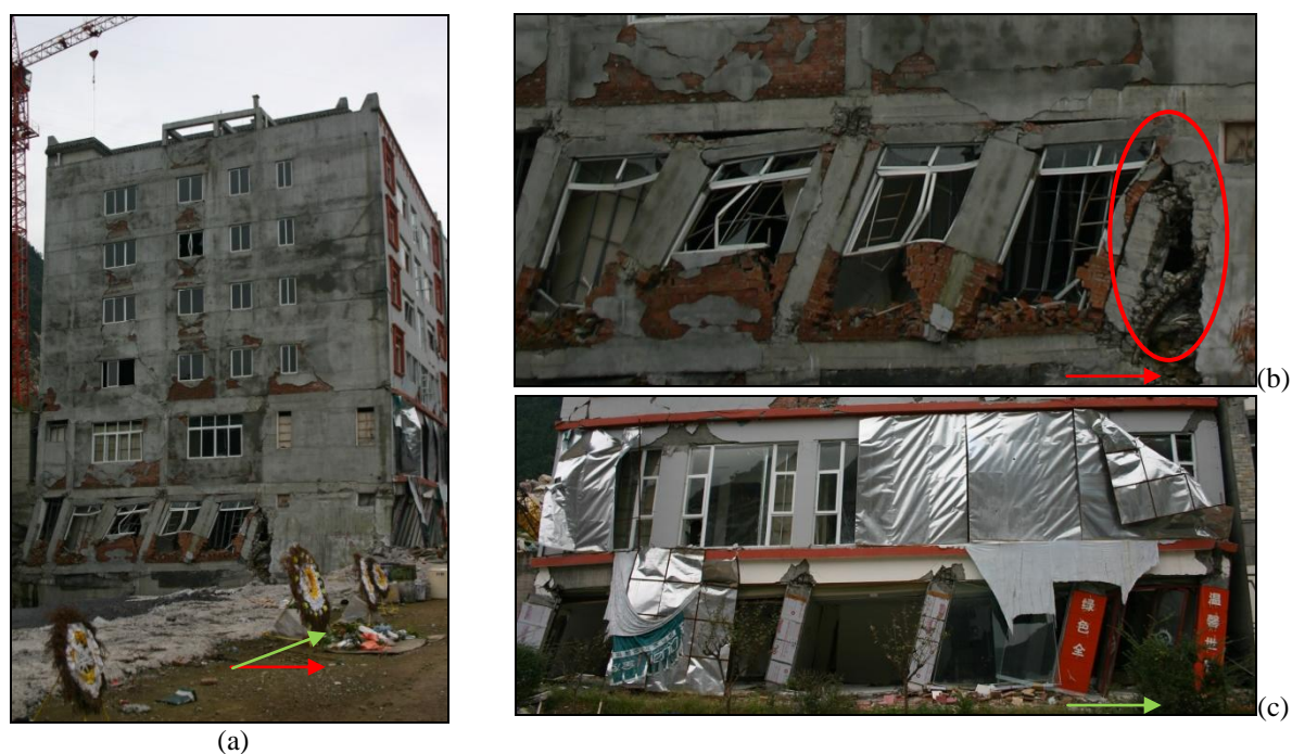
Figura 26: Mecanismo soft-storey formado nas duas direcções principais do edifício: a) vista lateral; b) Pormenor do mecanismo lateral com colapso de pilar; c) vista frontal com soft-storey devido à presença de lojas
