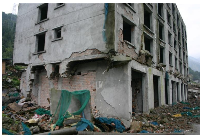
Figura 15: Edifício com estrutura em alvenaria confinada com pórticos de betão armado no R/C (Yingxiu)
