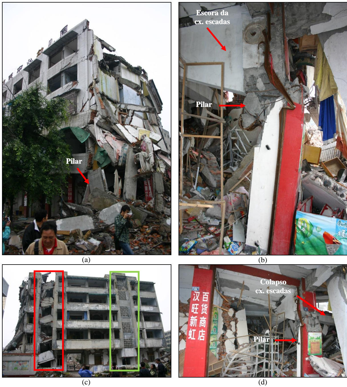
Figura 30: Colapso parcial por efeito da caixa de escadas: a) fachada anterior; b) colapso de pilar por corte devido à carga concentrada da caixa de escadas; c) fachada posterior e localização das caixas de escadas; d) caixa de escadas e pilar colapsado
