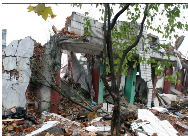
Figura 14: Restos de estrutura em alvenaria confinada com fachada do R/C em betão armado (Hanwang)
