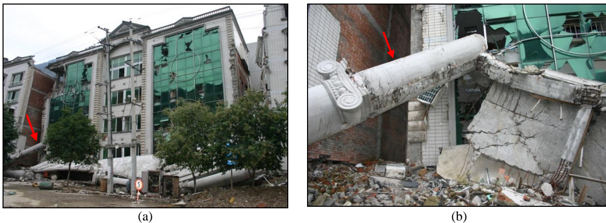
Figura 31: Colapso de edifício em betão armado por soft-storey devido a R/C com elevado pé-direito: a) vista geral; b) pormenorização das armaduras com bom confinamento dos pilares na zona dos nós e laje em betão armado
