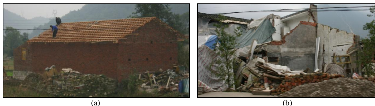
Figura 12: Edifícios em alvenaria estrutural não reforçada: a) em construção; b) colapso
