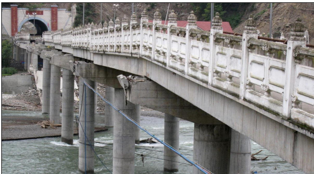
Figura 35: Deslocamento residual e colapso de tabuleiro por falta de apoio, com danos nos “shear-key” e apoio dos tabuleiros.
