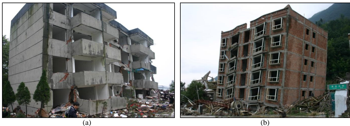
Figura 19: Colapso de edifícios em alvenaria confinada por soft-storey devido a igual resistência de corte basal em altura
