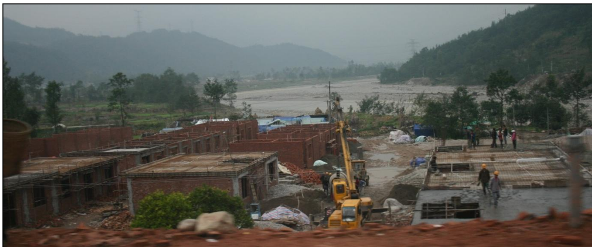
Figura 42: Reconstrução no distrito de Beichuan no leito do rio, com alvenaria confinada e lajes em betão armado.
