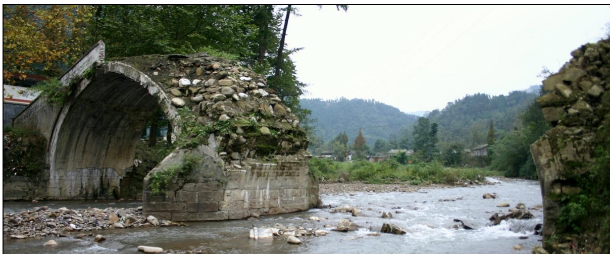
Figura 34: Ponte em alvenaria de pedra com colapso do arco central (Bailu)
