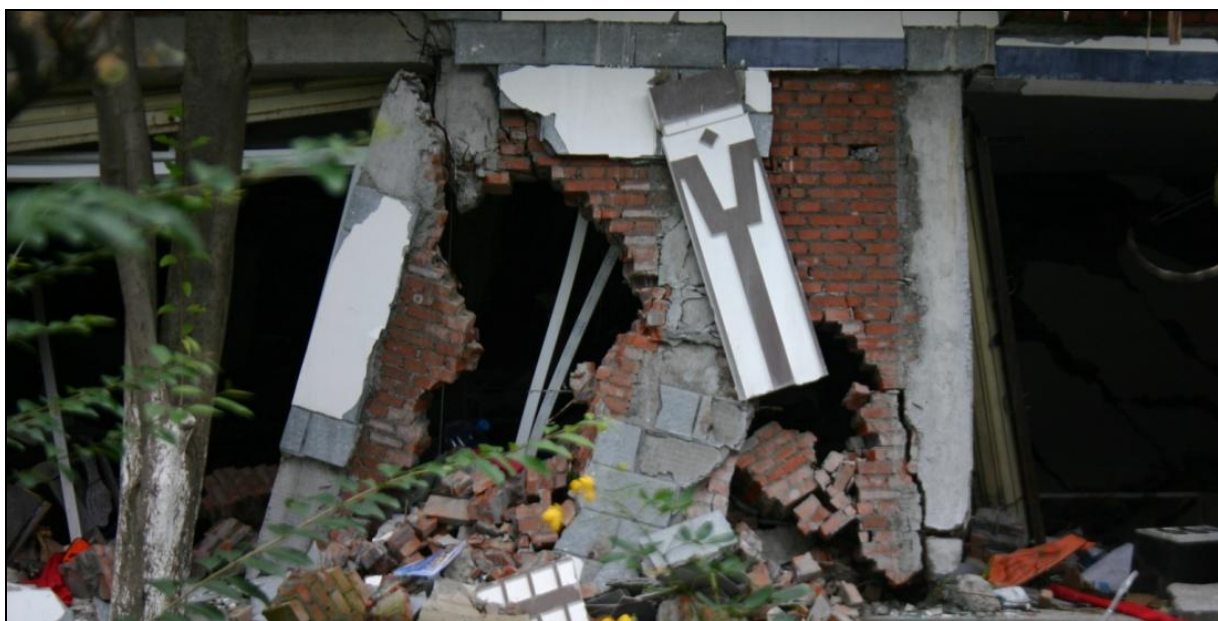
Figura 25: Ruptura por corte de pilares devido ao efeito de escora da alvenaria confinada (Beichuan)
