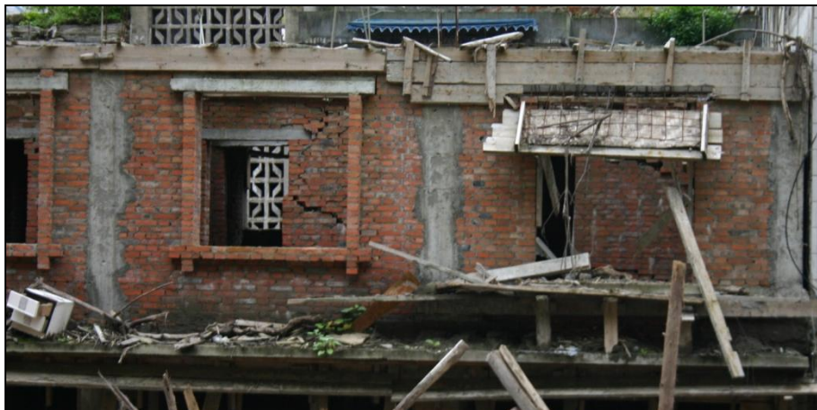
Figura 13: Sistema estrutural em alvenaria confinada com “shear connectors” (Beichuan)
