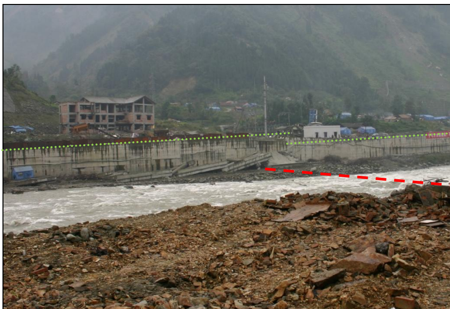
Figura 5: Ruptura superficial em Yingxiu, com representação da linha da falha (a vermelho) e posição da estrada após o sismo (linhas verdes): a) margem esquerda do rio; b) margem direita do rio
