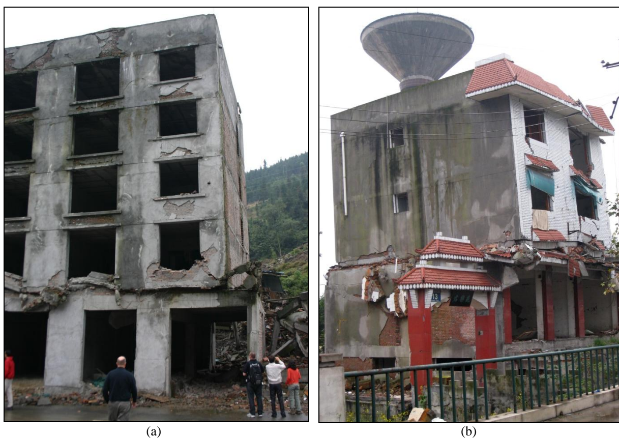
Figura 20: Colapso por soft-storey do 1º piso devido à mudança de rigidez em altura: a) Yingxiu; b) Hanwang
