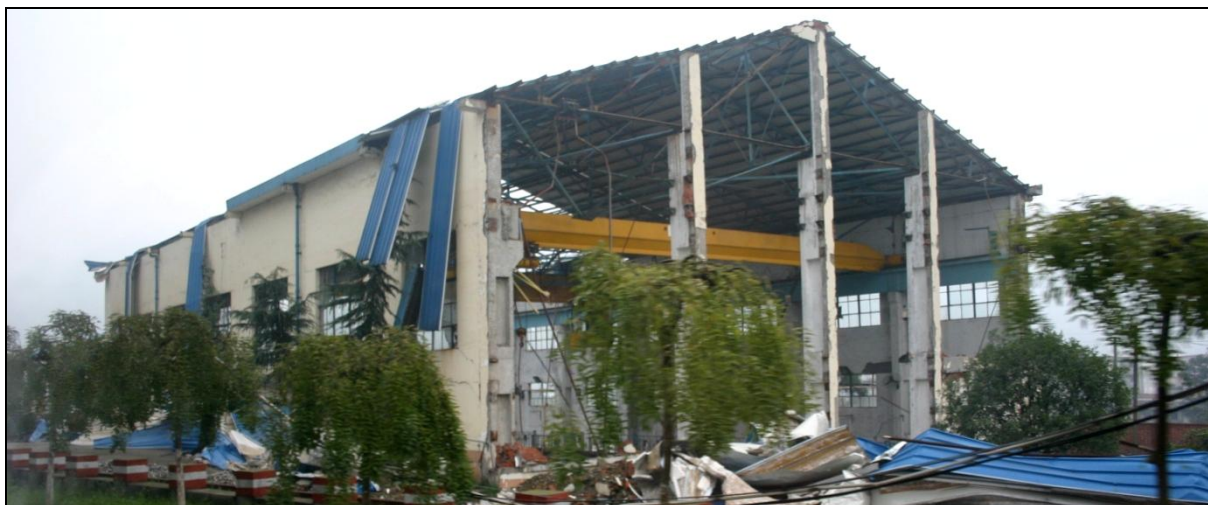
Figura 17: Pavilhão industrial com estrutura pré-fabricada, painéis de enchimento em alvenaria e cobertura metálica (Hanwang)
