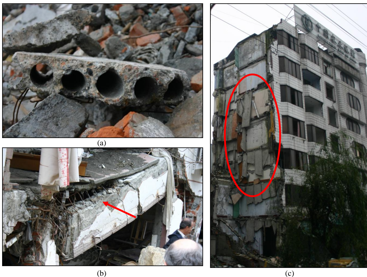
Figura 16. Constituição dos painéis de laje (Hanwang): a) pormenor; b) ligação às vigas; c) dano mais correntemente observado (deficiente ligação entre elementos)
