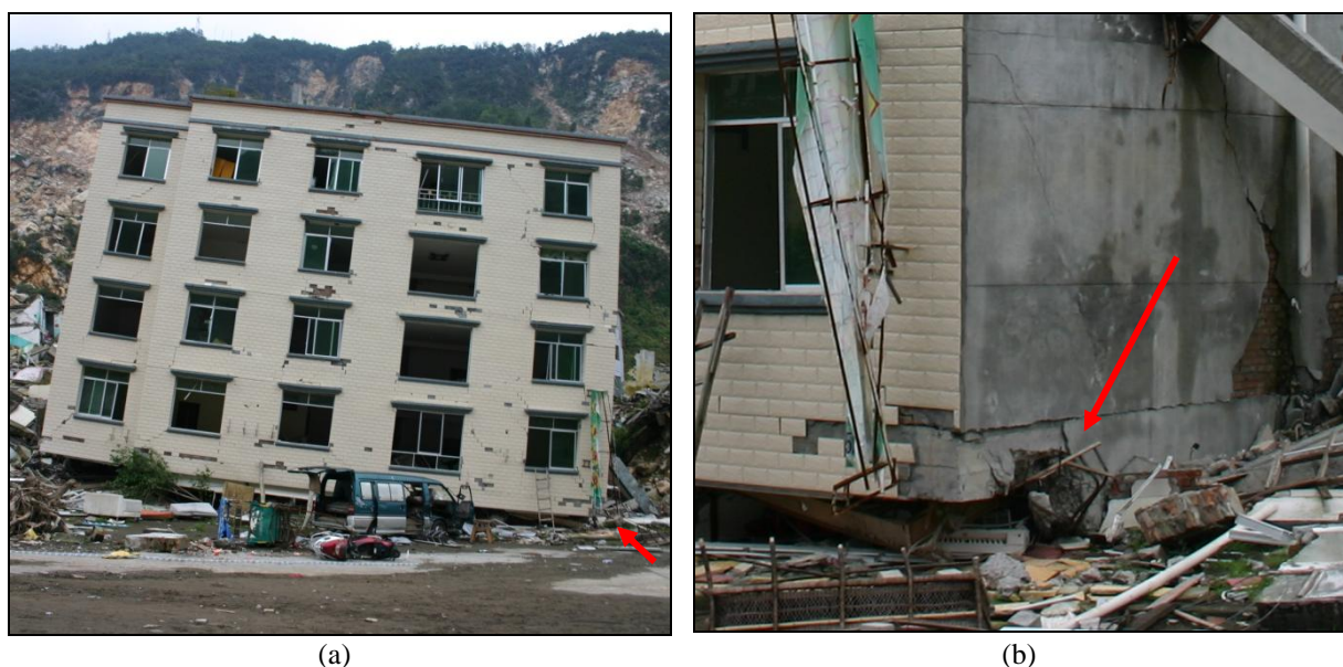
Figura 22: Colapso por soft-storey da estrutura porticada do R/C em betão armado (Beichuan) com restante estrutura em alvenaria confinada: a) vista geral; b) pormenor
