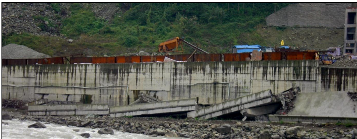
Figura 36: Colapso de ponte provocado por ruptura superficial da falha (Yingxiu)
