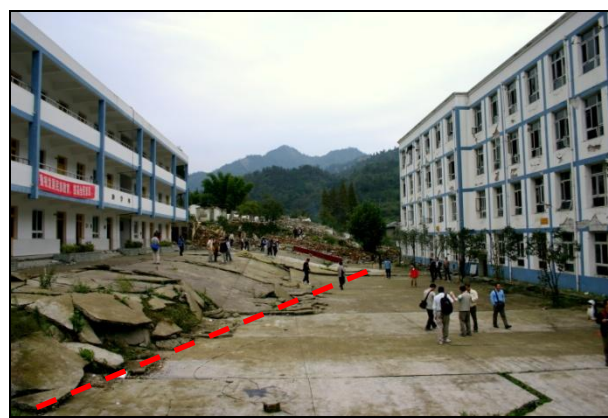
Figura 6: Escola de Bailu com ruptura superficial da falha: a) antes; b) depois do sismo
