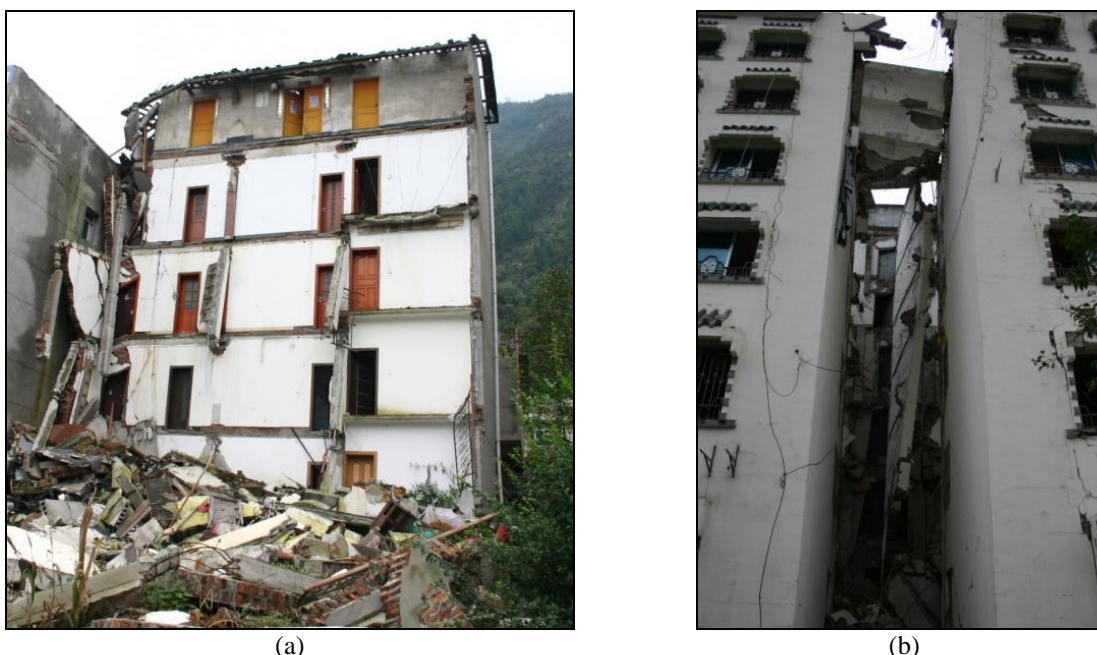
Figura 33: Colapsos na zona das caixas de escadas (Beichuan): a) colapso da fachada com portas para a entrada dos apartamentos visível; b) colapso parcial apenas na zona da caixa de escadas
