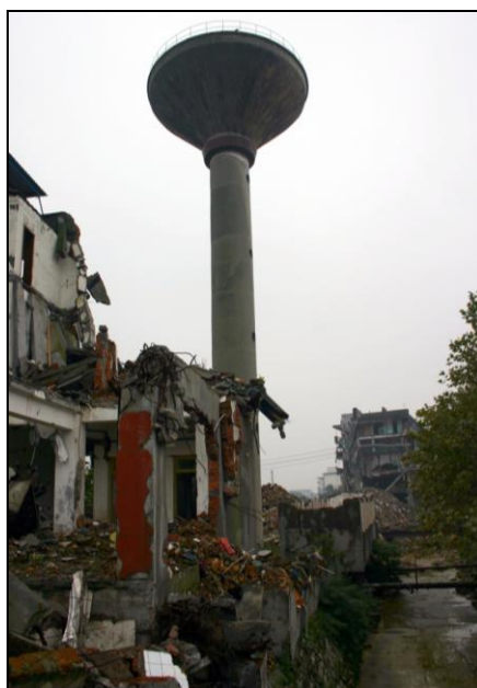
Figura 39: Reservatório de água – comportamento de pêndulo invertido (Hangwang)
