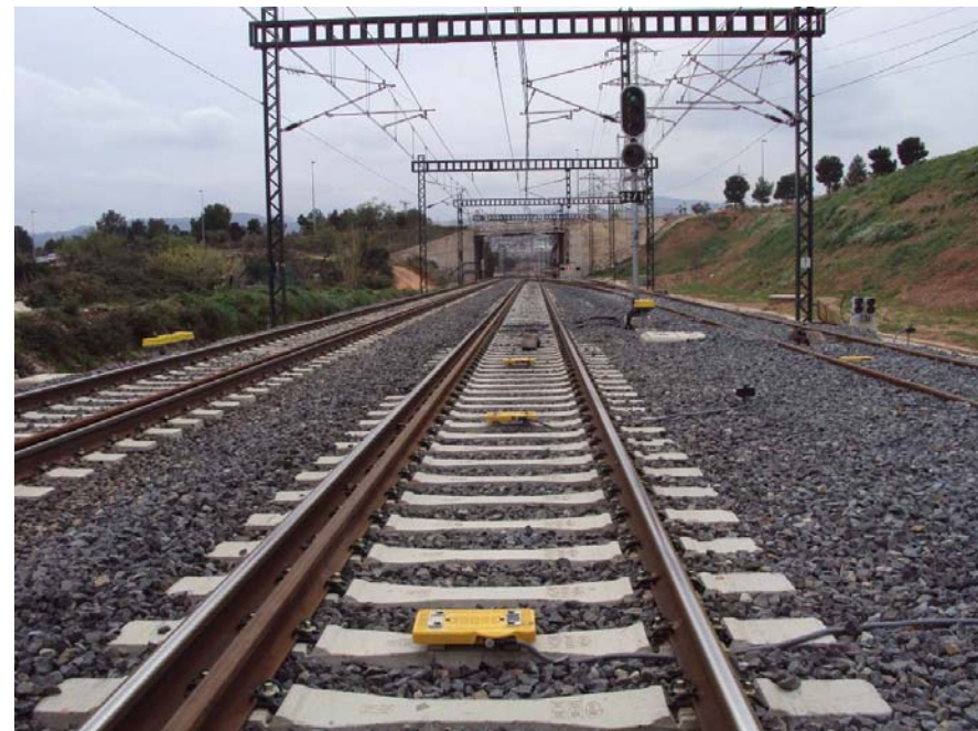
Via de bitola mista (ibérica/standard) c/ Eurobalizas de ERTMS nivel 1 (fonte: ADIF)
