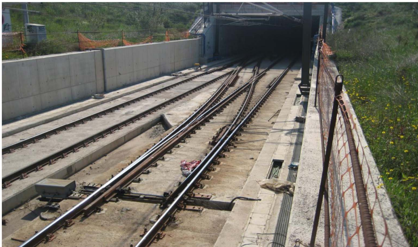
Comunicação à entrada do túnel Casa Tunis com cruzamento obtuso na agulha (fonte: ADIF)
