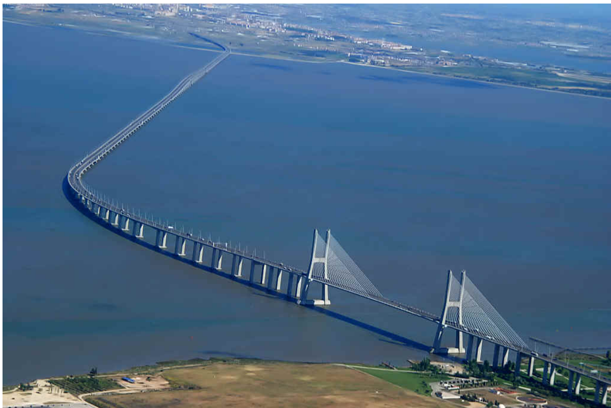
Figura 7 – Ponte Vasco da Gama: vista do lado Norte
