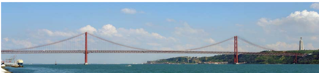
Figura 4 – Ponte 25 de Abril: vista geral
