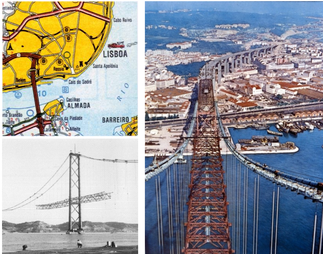
Figura 3 – Ponte 25 de Abril: fases de construção
