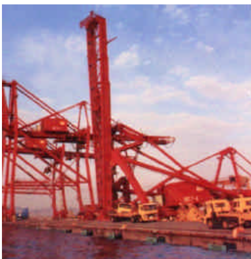
Figura 4 - Danos em equipamentos no porto de Kobe no Japão, devidos ao sismo de 17 de Janeiro de 1995 [3]
