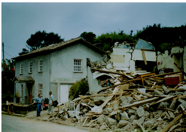
Figura 2 – Diferença de vulnerabilidade em edifícios - sismo do Faial, 8 de Julho de 1998.
