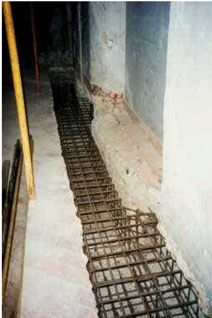
Edifícios de alvenaria - reforço estrutural com transferência de cargas
