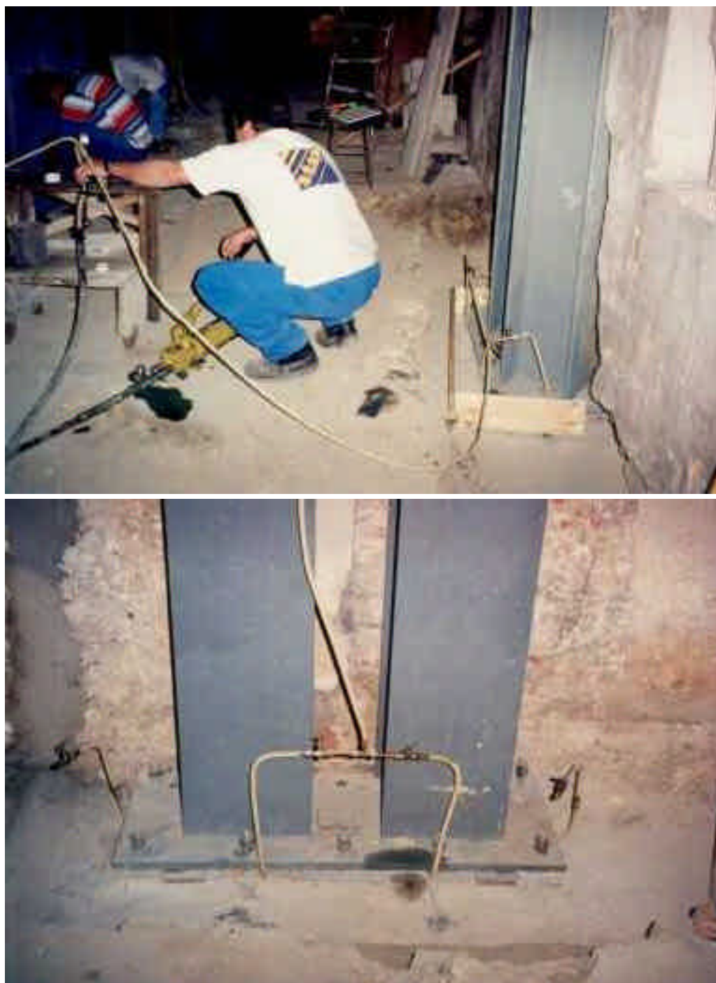
Edifícios de alvenaria - reforço estrutural com transferência de cargas
