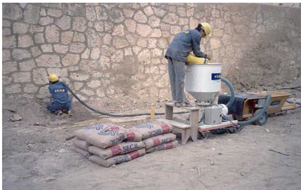
Edifícios de alvenaria - injeções de consolidação
