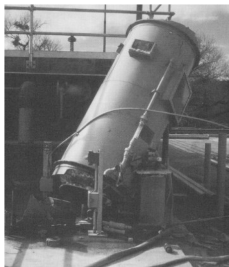
Figura 5 - Derrubamento de equipamento de purificação de ar de uma estação de tratamento durante o sismo de Northridge, 1994 [4]
