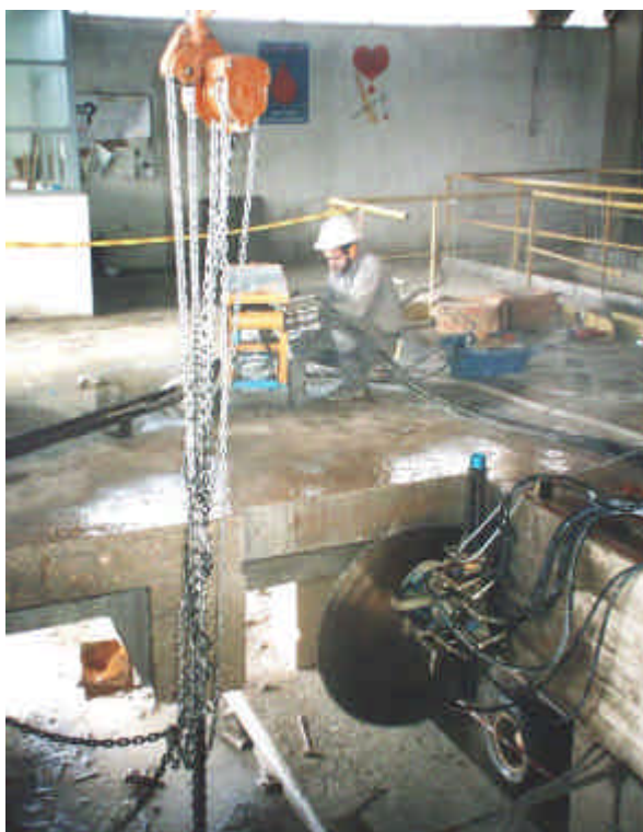
Edifícios de betão armado - alterações estruturais
