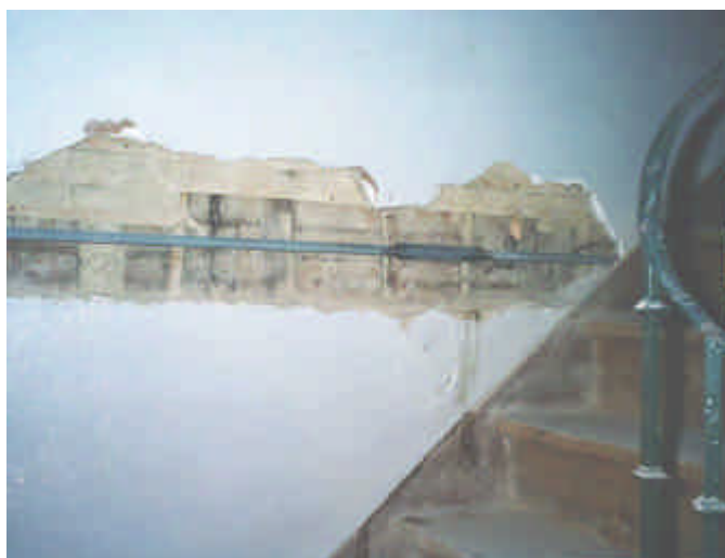
Edifícios de alvenaria - execução de tirantes clássicos
