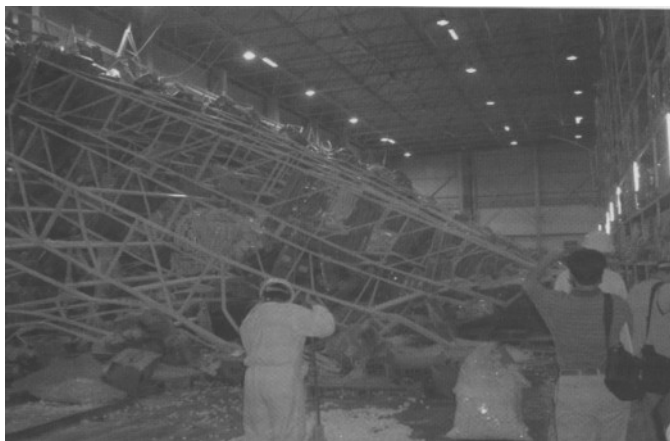
Figura 2 – Queda das prateleiras do armazém na fábrica de produtos farmacêuticos Toprak Ilic
