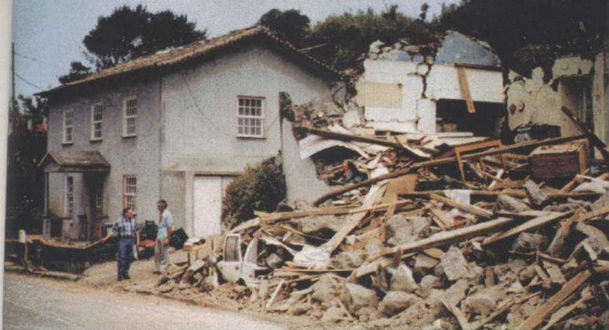
Figura 1 - Diferença de vulnerabilidade entre edifícios. Sismo do Faial de 9 de Julho de 1998 (Carvalho, 2001)
