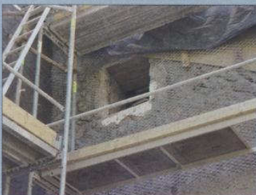
# 5 - Reforço de parede alvenaria
