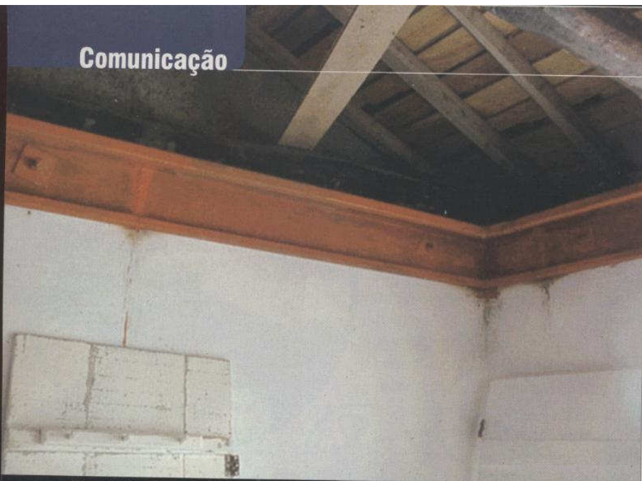
Figura 4 - Ligação paredes/telhado com uma cantoneira metálica (Costa, 2003)
