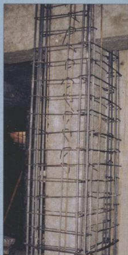
# 1 - Reforço de pilar com encamisamento em betão armado
