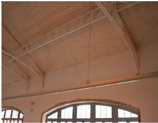
Ginásio interior – reforço de cobertura
