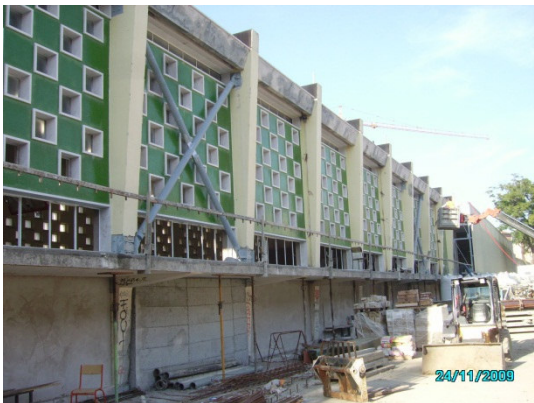
Ginásio exterior – travamento
