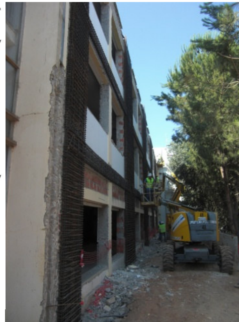
Edifício principal (III)
