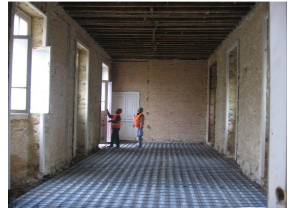
Novo pavimento (diafragma rígido)
