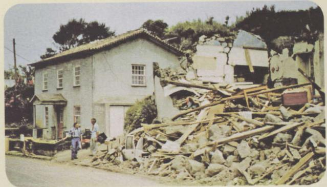
Figura 3 - Diferença de resistência sísmica entre construções (Lopes, 2008)
