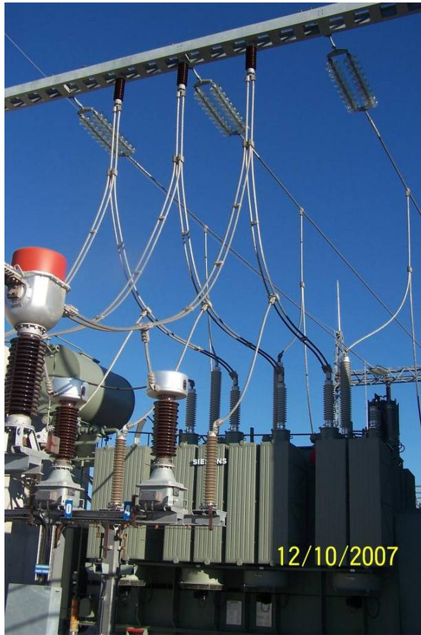
Figura 3.3 – Transformador com apoios flexíveis na subestação de Estói
