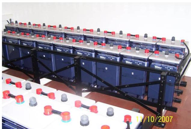
Figura 7.22 - Sistemas de suporte de baterias na subestação de Tunes
