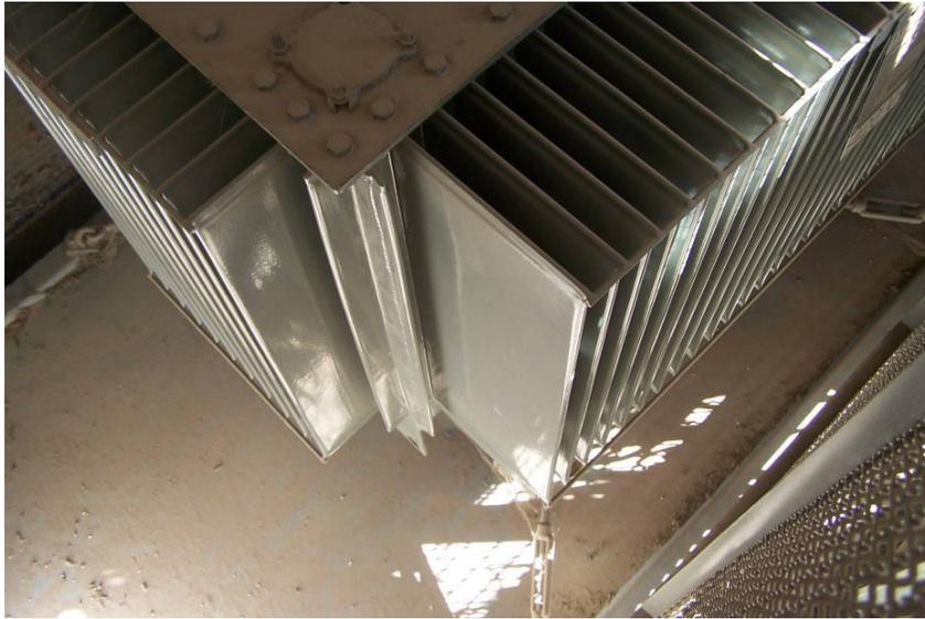
Figura 7.11 - PT LLE 0893 com os movimentos do transformador bloqueados por esticadores
