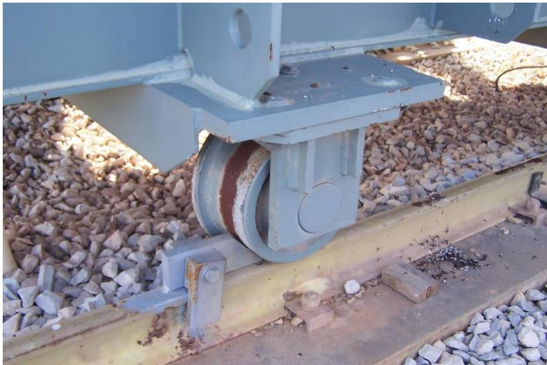
Figura 7.9 - Sistema de travamento do transformador da subestação de S. Bartolomeu de Messines com bloqueador soldado ao perfil de apoio das rodas
