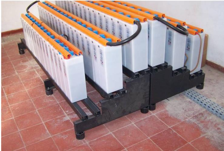
Figura 7.25 - Sistemas de suporte de baterias na subestação de Loulé
