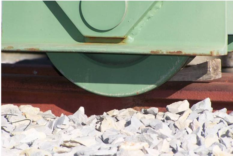
Figura 7.8 - Travamento ineficiente de uma roda de transformador na subestação de Braciais
