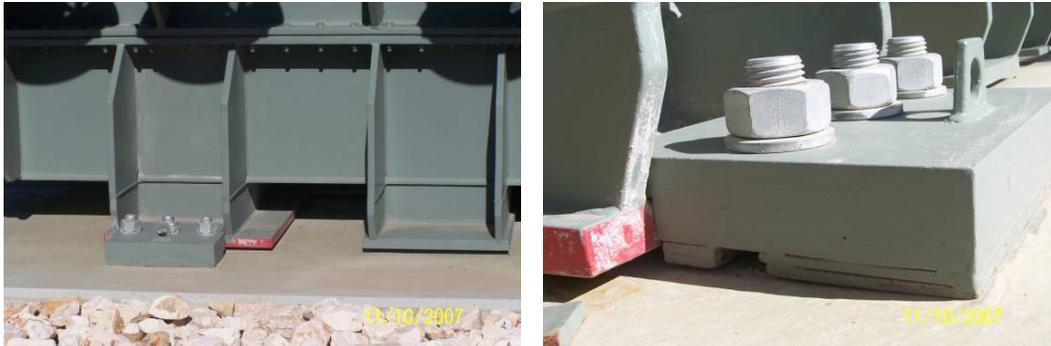
Figura 7.4 - Detalhes do sistema de fixação do transformador ancorado de Portimão
