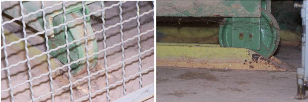
Figura 4.17 - Transformador de PT com rodas sujas
