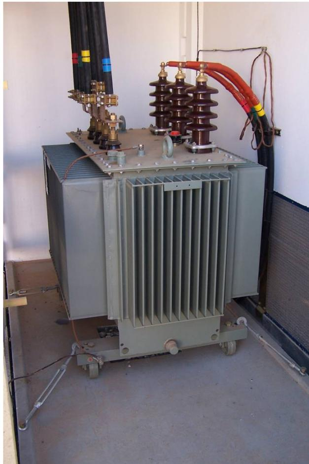
Figura 6.3 - Transformador do PT ABF 570 com movimentos impedidos por esticadores
