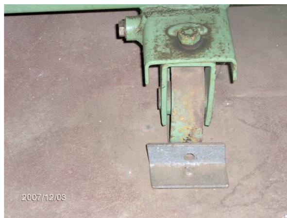
Figura 4.16 - Roda de transformador com movimento restringido por cantoneira aparafusada
