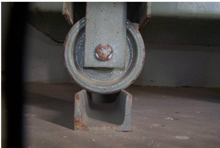
Figura 7.13 - Transformador apoiado com rodas na transversal ao perfil U de apoio
