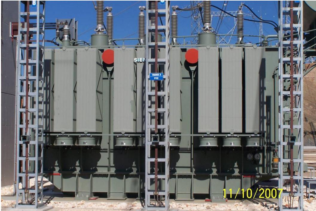
Figura 6.2 – Transformador ancorado à fundação na subestação de Portimão.
