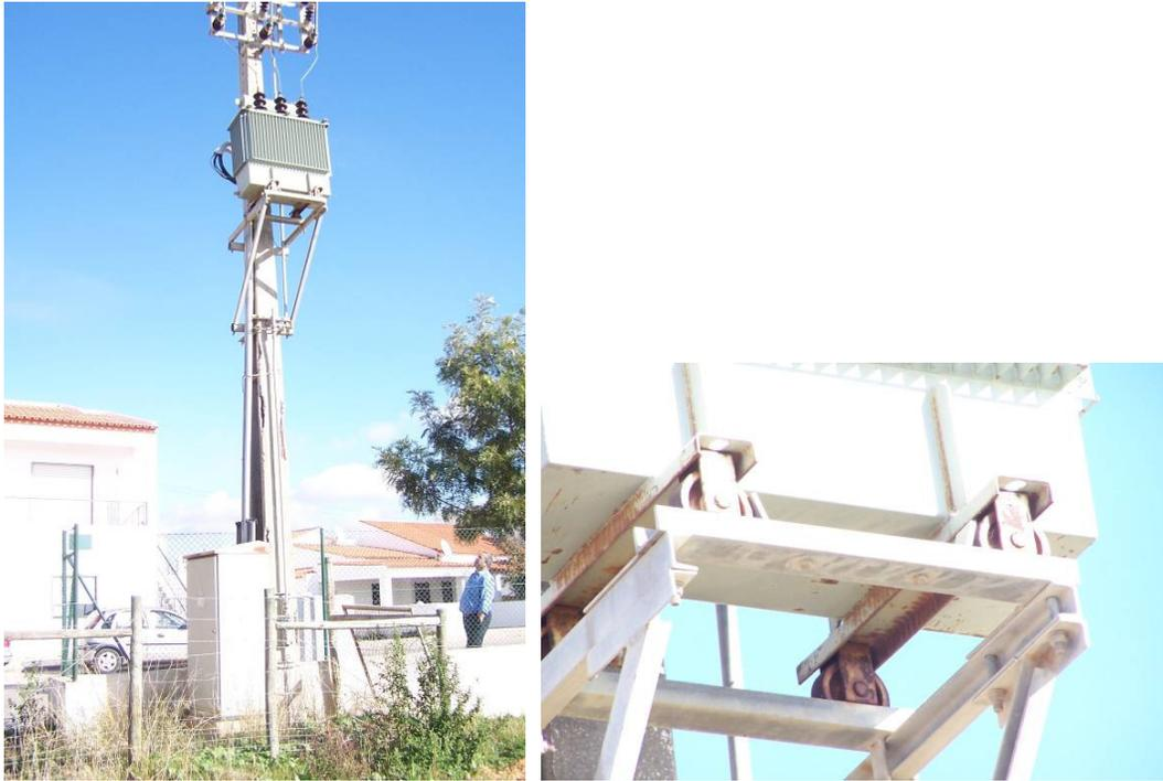
Figura 7.19 - PT aéreo ABF 39. Transformador com translação bloqueada e a rotação livre
