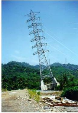
Figura 5.7 – Danos numa torre de alta tensão devido a deformações do solo (Earthquake Spectra, 2001)
