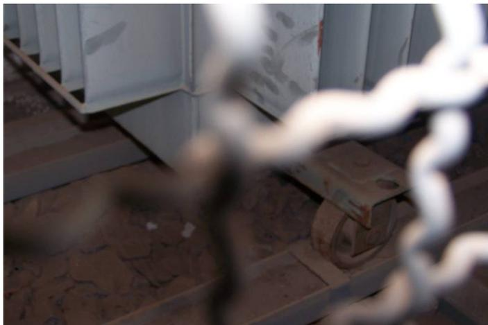
Figura 4.15 - Transformador com roda travada por peça metálica ligada ao perfil de apoio
