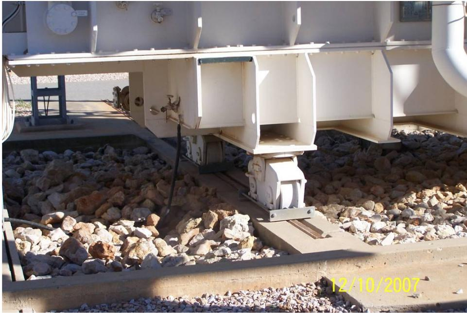
Figura 6.1 – Transformador não ancorado à fundação na subestação de Estoi
