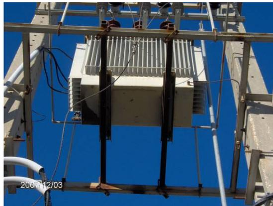
Figura 7.20 - PT aéreo FAR 88 com dois postes e transformador poisado na estrutura de suporte
