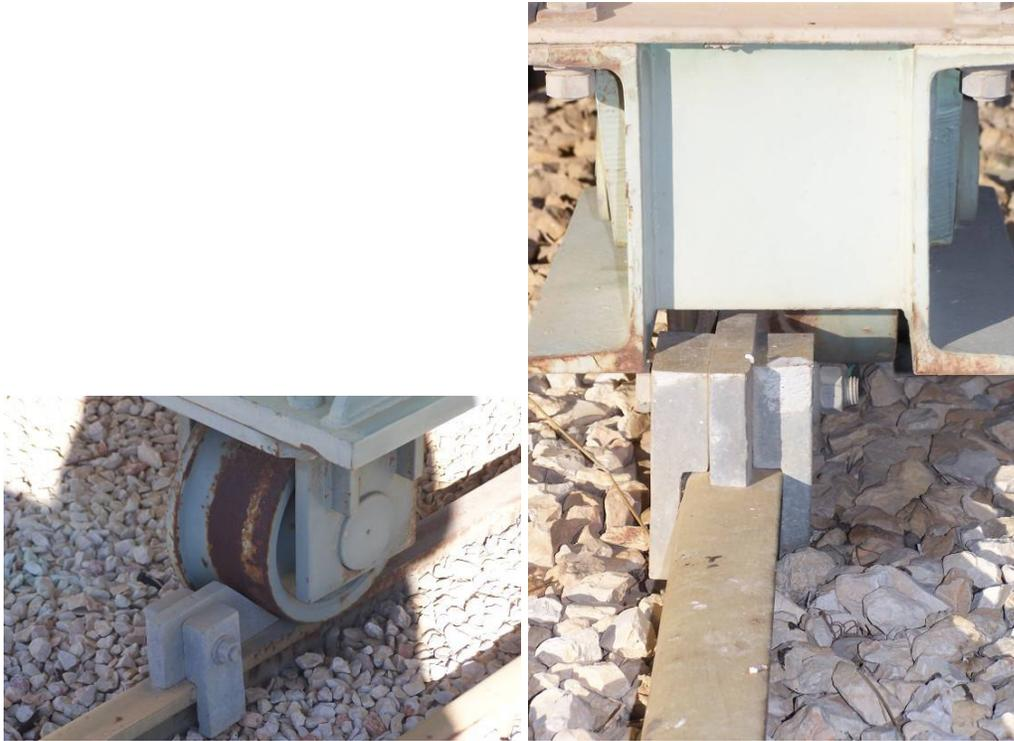
Figura 7.7 - Travamento de rodas por peças metálicas aparafusadas nas subestações de Albufeira e de Aldeia Nova
