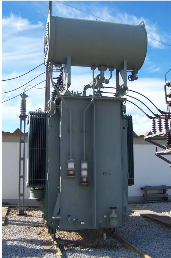
Figura 7.6 - Transformador com ligações flexíveis no topo na subestação de S. Bartolomeu de Messines
