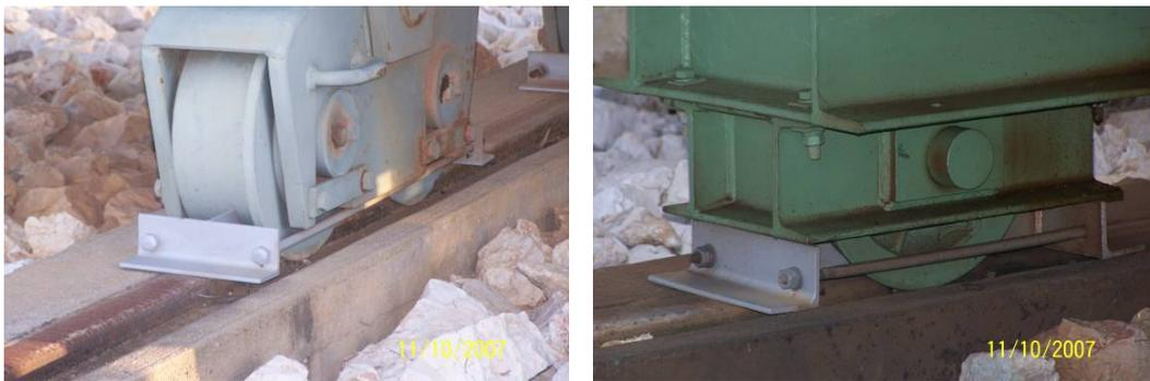
Figura 4.2 - Travamento das rodas de 2 transformadores não ancorados na subestação de Tunes
