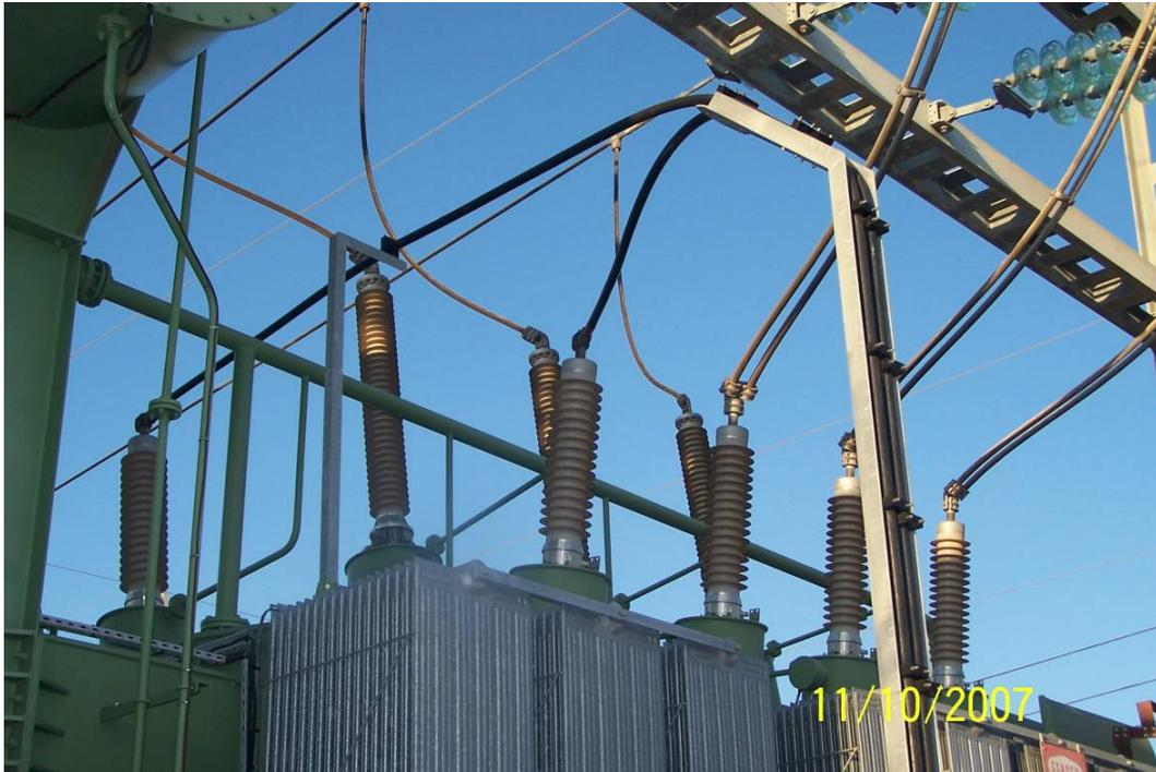
Figura 7.1 - Ligações no topo de transformador não ancorado na subestação de Tunes
