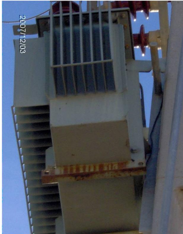
Figura 7.18 - PT aéreo FAR 012 com o transformador suspenso do poste por ganchos
