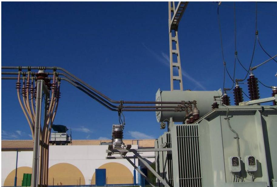
Figura 7.5 - Transformador com ligações rígidas na subestação de Albufeira
