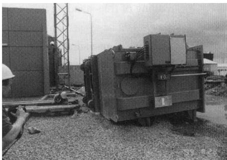
Figura 5.5 – Transformador da fábrica EnerjiSA após o sismo (Earthquake Spectra, 2000)
