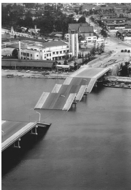
Figura 2 – Colapso por rotação dos pilares devido a liquefacção, “Showa Bridge”, Niigata, 1964 (Chen e Duan, 2003)
