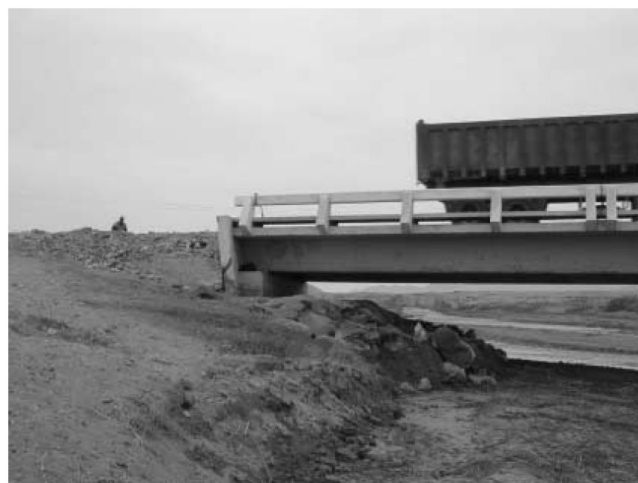
Ponte Los Banos, Peru, 2001
