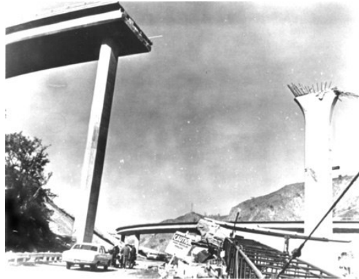
Figura 10 – Queda de troço de tabuleiro, sismo de San Fernando, 1971. ( http://earthquake.usgs.gov )
