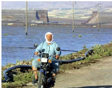
Acidente na barragem Zeyzoun, Síria, Maio 2002
