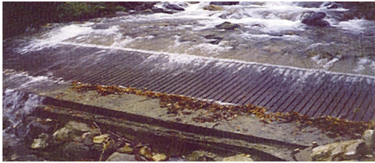
Figura 1 – Inserção de uma tomada de água do tipo Tirolois num pequeno curso de água (adaptado de ESHA, 1994).
