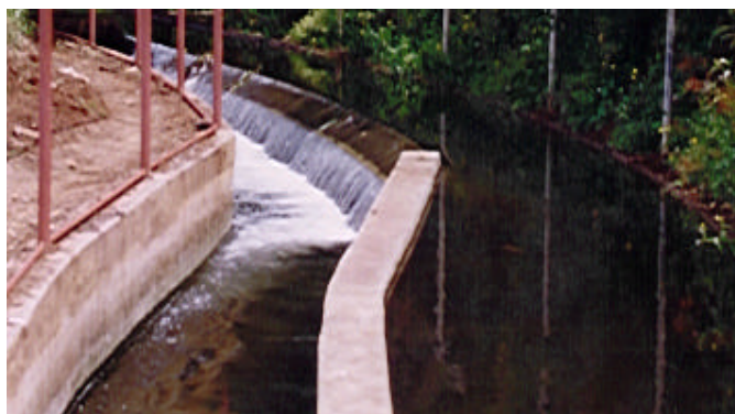
Fig. 10 – Vista do descarregador lateral do canal de rega para o canal de adução de um aproveitamento hidroeléctrico tipo
