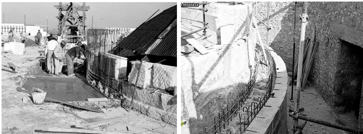
Figura 3. Esquerda: Início da construção do anel de betão armado: laje de betão armado à cota 25 m; Direita: Pormenor da parede de betão armado e alvenaria de tijolo do corpo cilíndrico interior e parede de betão ciclópico do corpo cilíndrico exterior. Fonte: [2].
