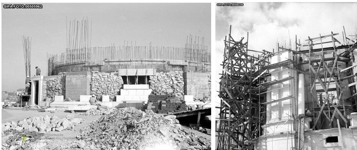
Figura 4. Construção do tambor da cúpula. Fonte: [2].
