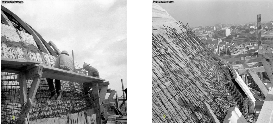
Figura 5. Esquerda: Construção da cúpula interior; Direita: Construção da cúpula exterior. Fonte: [2].
