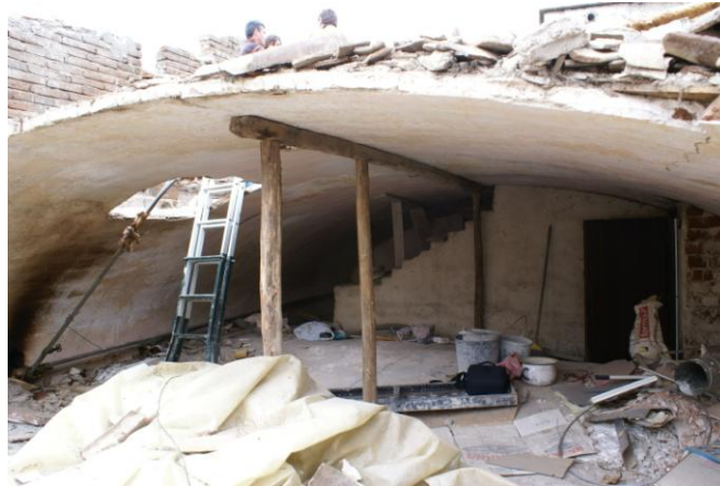
Figura 6. Exemplo de abobadilha cilíndrica executada sem o enchimento no extradorso.
