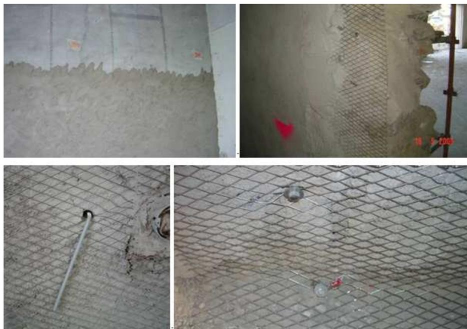
Figura 2: Aplicação do reboco sobre a malha de metal distendida (em cima) e pregagem da malha metálica à alvenaria (em baixo à esquerda) e à laje do pavimento (em baixo à direita).
