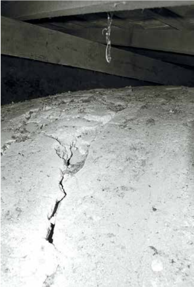
56. Vistas do extradorso das abóbadas da capela do Espírito Santo, antes da intervenção (em cima) e após limpeza das argamassas desagregadas (em baixo).
