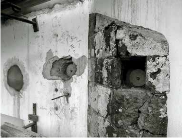
68. Furações para colocação de sistema de ancoragem de tirantes.
