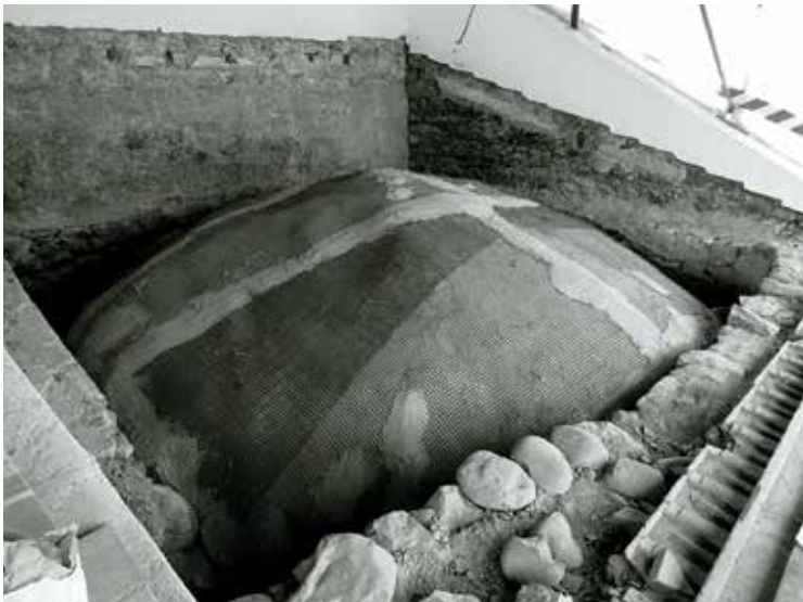
66. Camada de argamassa e malha de fibra de carbono no extradorso da abóbada da capela do Espírito Santo.
