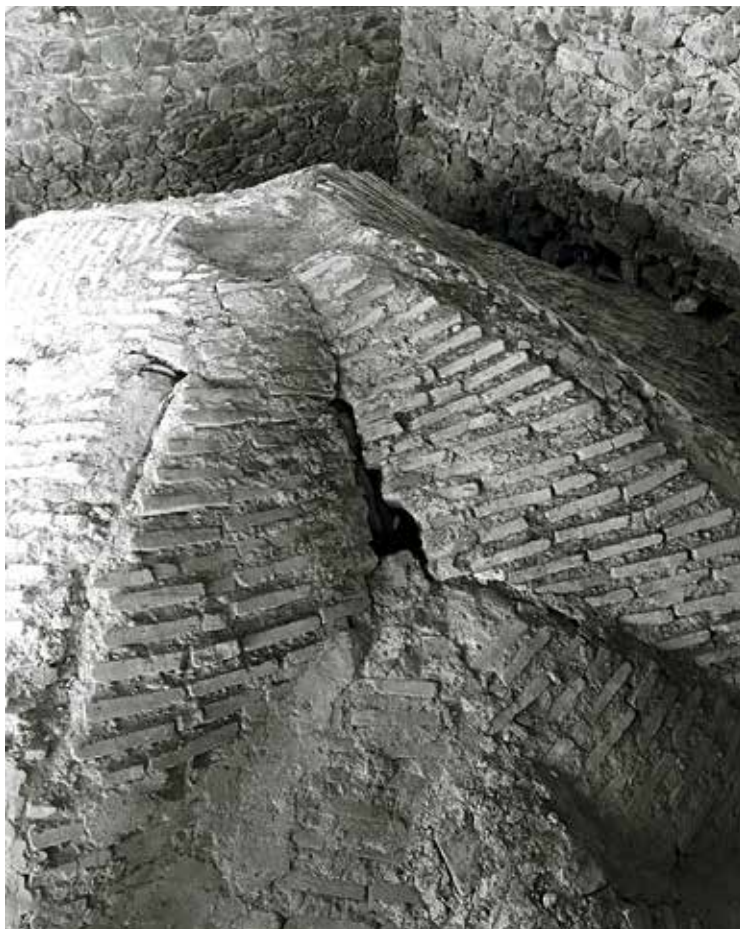
57. Vistas do extradorso das abóbadas da capela de São João, antes da intervenção (em cima) e após limpeza das argamassas desagregadas (em baixo).
