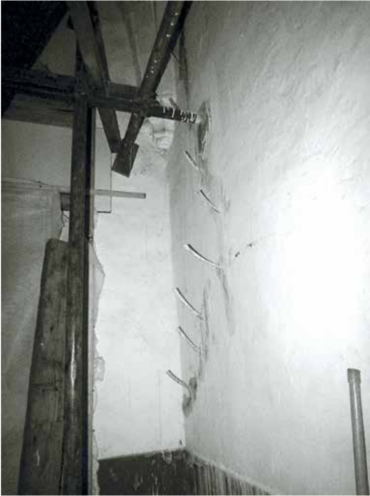
65. Injeção de caldas nas paredes das capelas.
