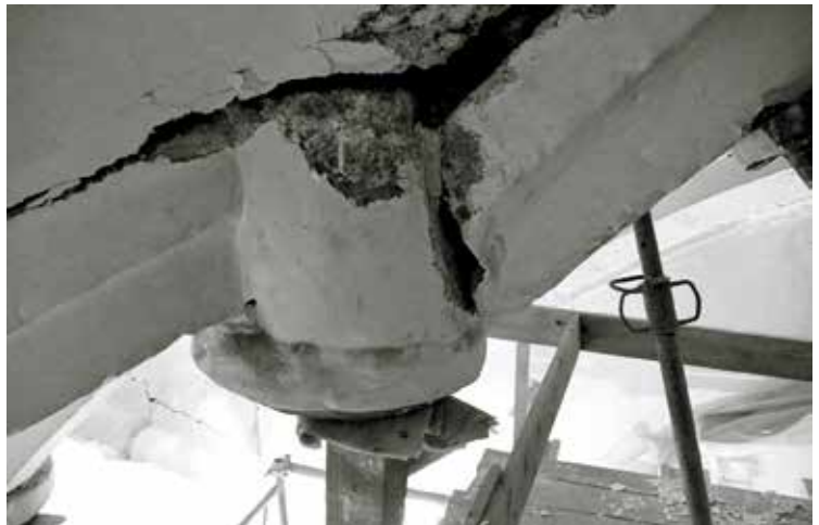
55. Fissuras e deslocamentos, antes da intervenção, da capela do Espírito Santo (em cima) e da capela de São João (em baixo).
