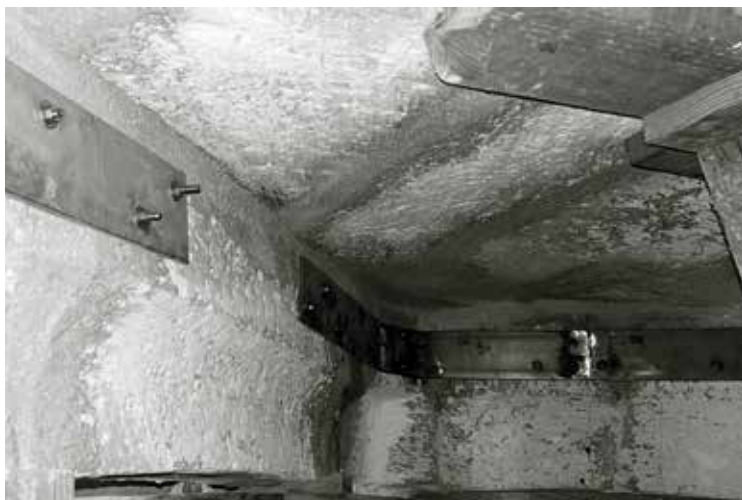
61. Fixação de aduelas deslocadas da capela do Espírito Santo.
