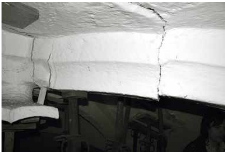
60. Aduelas deslocadas nas nervuras da capela do Espírito Santo.
