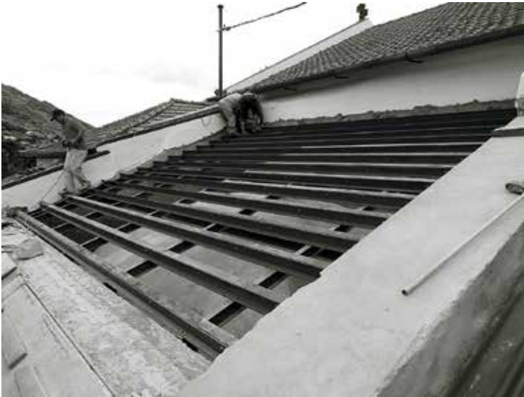
69. Estrutura do novo revestimento de abóbada da capela de São João.
