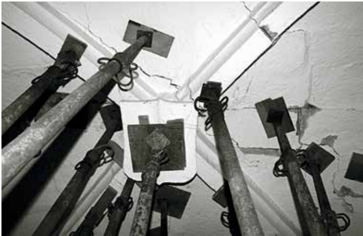
54. Sistema de escoramento provisório, antes da intervenção, da capela do Espírito Santo (em cima) e da capela de São João (em baixo).
