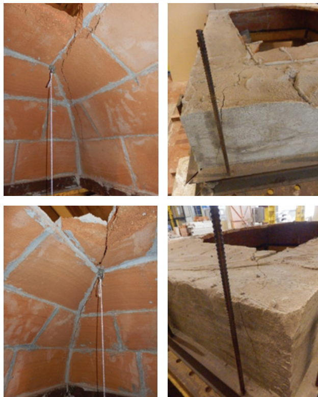
Figura 18 Fissuração nas vizinhanças das arestas
