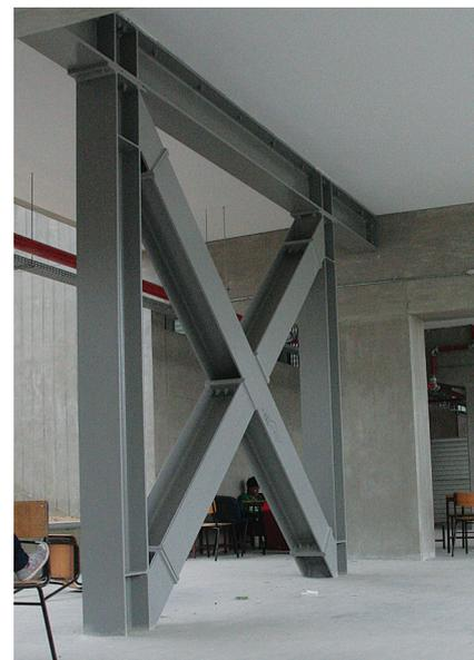
Fig. 11 – Aspecto final da estrutura de reforço do bloco A3 ao nível do piso 0
