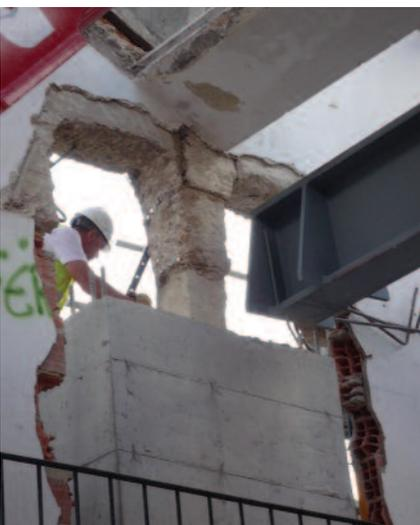
Fig. 9 – Introdução da extremidade nascente da viga metálica, vendo-se o trecho de pilar preexistente
