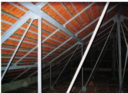
Fig. 5 – Asna metálica da cobertura
