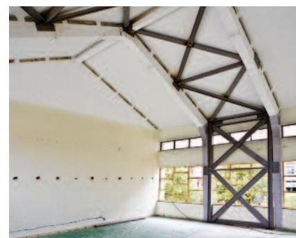
Fig. 10 – Solução de reforço longitudinal, no piso superior do ginásio
