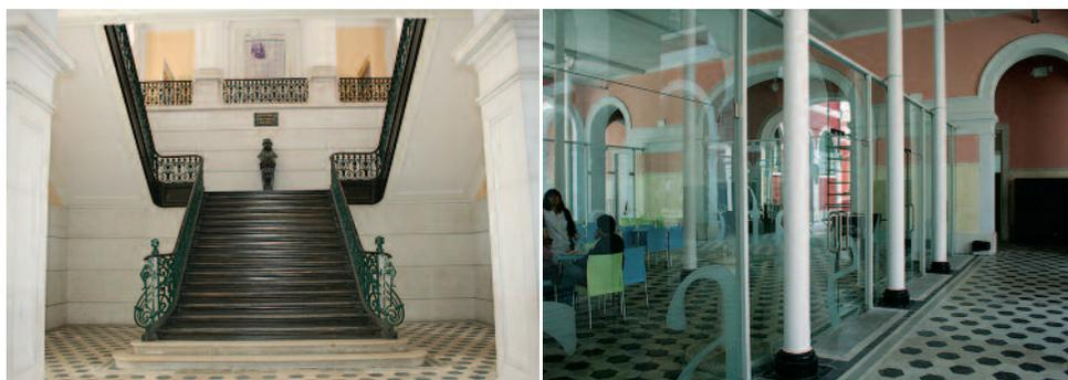
Fig. 12 – Escadaria central. Colunas metálicas de apoio do anfiteatro
