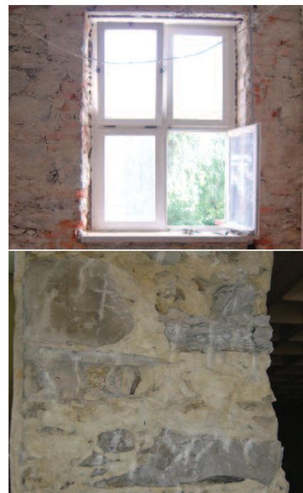
Fig. 3 – Paredes exteriores em alvenaria de pedra
