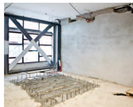
Fig. 11 – Solução de reforço longitudinal, no piso inferior do ginásio
