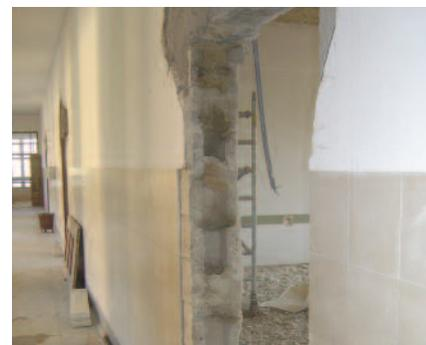
Fig. 4 – Paredes interiores em alvenaria de blocos de betão
