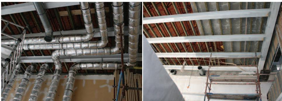
Fig. 17 – Laje de esteira para apoio dos aparelhos de AVAC
