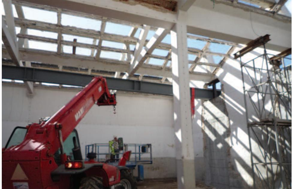
Fig. 10 – Introdução da extremidade da viga do lado poente, com necessidade de colocação de um escoramento de apoio do trecho de parede interessada
