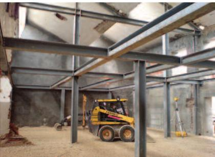
Fig. 8 – Estrutura principal montada à espera de receber as lajes colaborantes
