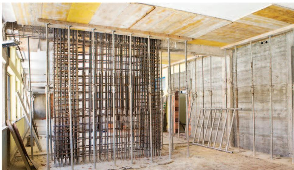
Fig. 9 – Paredes transversais e longitudinais de reforço de um dos blocos do edifício principal, próximo de junta de dilatação
