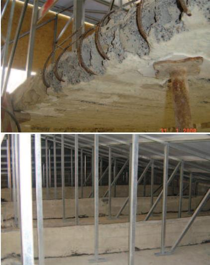
Fig. 5 – Laje de esteira aligeirada apoiada em vigas de betão armado invertidas
