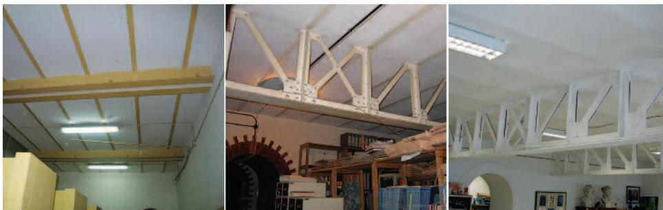
Fig. 1 – Vigas mestras ao nível do piso térreo. Tipos 1, 2 e 3
