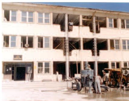
Fig. 18 – Adição de armaduras metálicas exteriores e encamisamento de pilares em edifício escolar na Turquia (Polat Gülkan)
