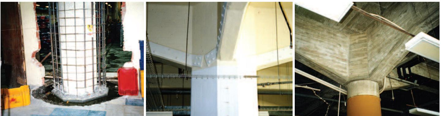
Fig. 14 – Encamisamento de pilares e adição de barras de aço para reforço de vigas (Júlio Appleton)
