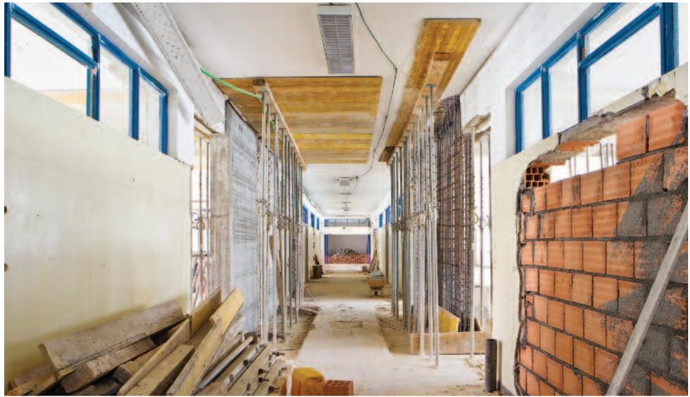
Fig. 8 – Paredes longitudinais de reforço de um dos blocos do edifício principal
