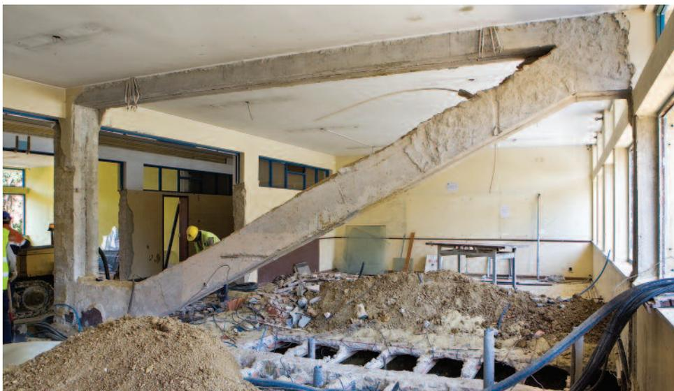
Fig. 4 – Diagonais de travamento transversal da estrutura numa das juntas de dilatação entre blocos do edifício principal
