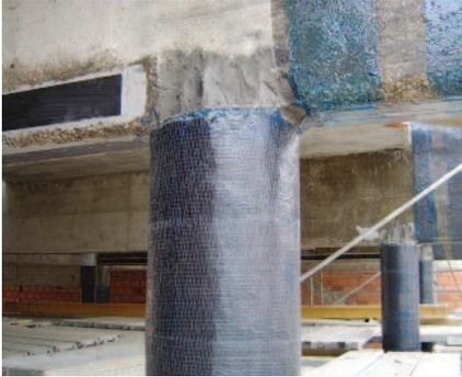
Fig. 16 – Aplicação de manta de CFRP em zona crítica de pilar (VSL Sistemas Portugal, S.A.)
