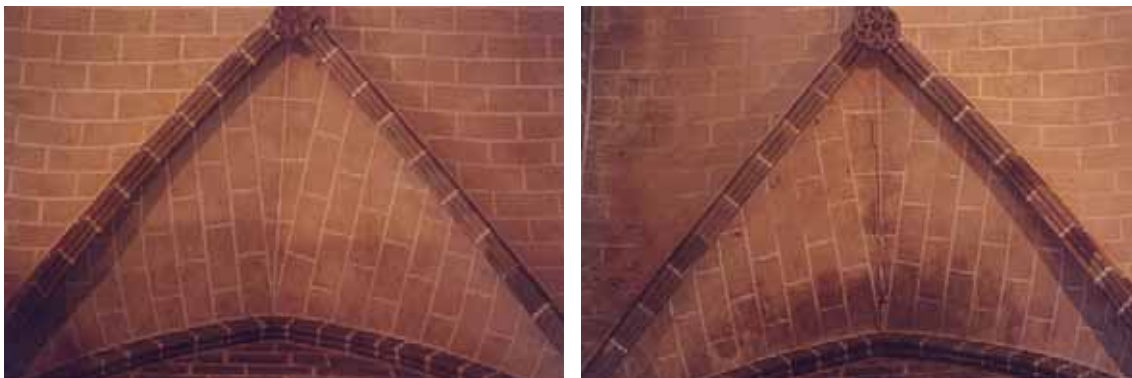
Figura 6.23 - Pormenores das lunetas do 7º tramo: esquerda - lado Norte; direita - lado Sul.
