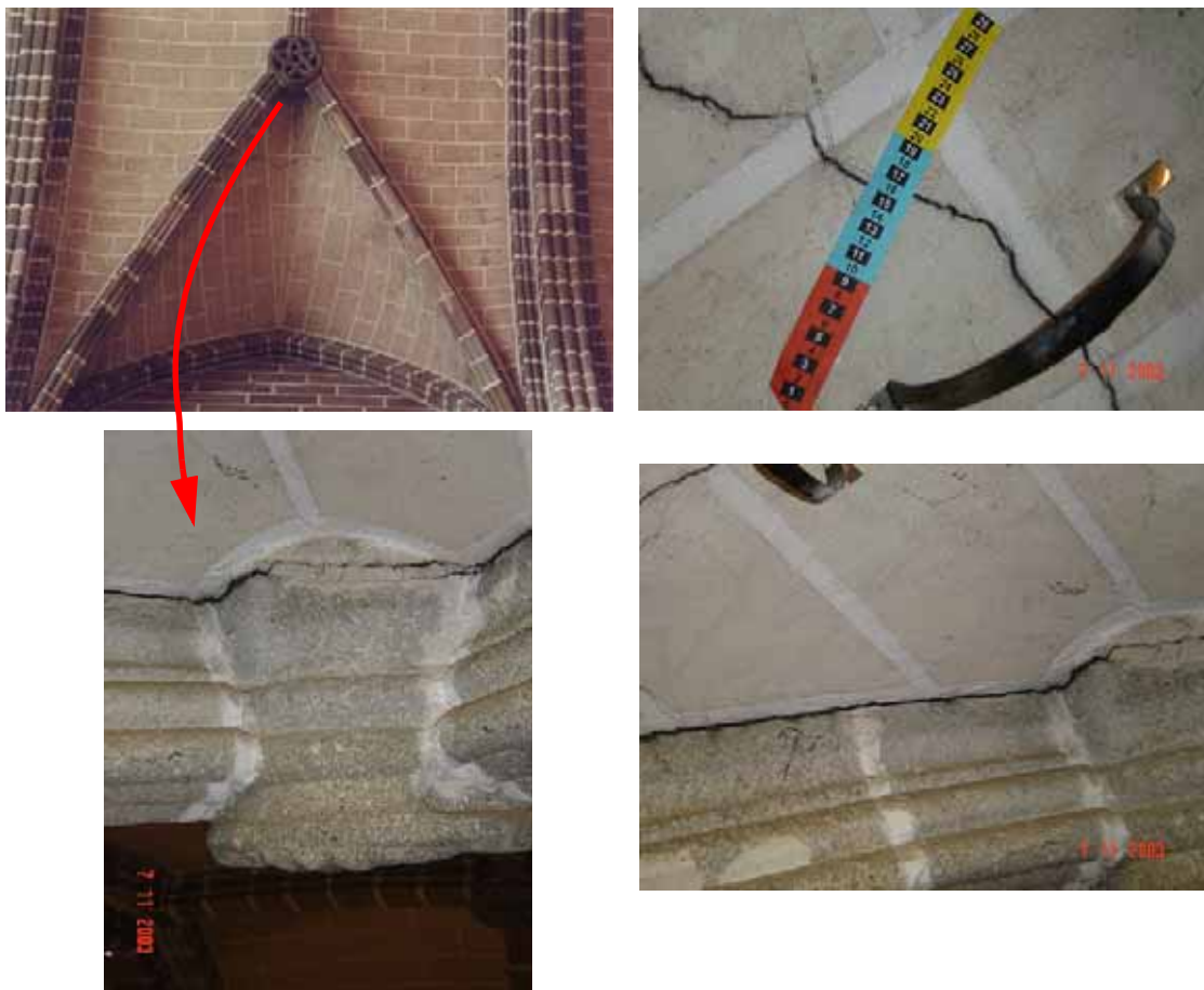
Figura 6.14 - Pormenores da luneta do 2º tramo do lado Norte.
