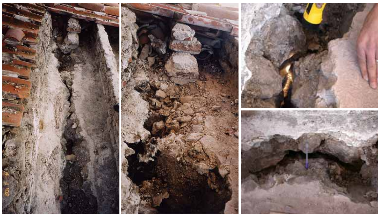
Figura 6.5 - Vistas superiores (pelo lado da cobertura) da fenda da luneta do 3º tramo do lado Sul.
