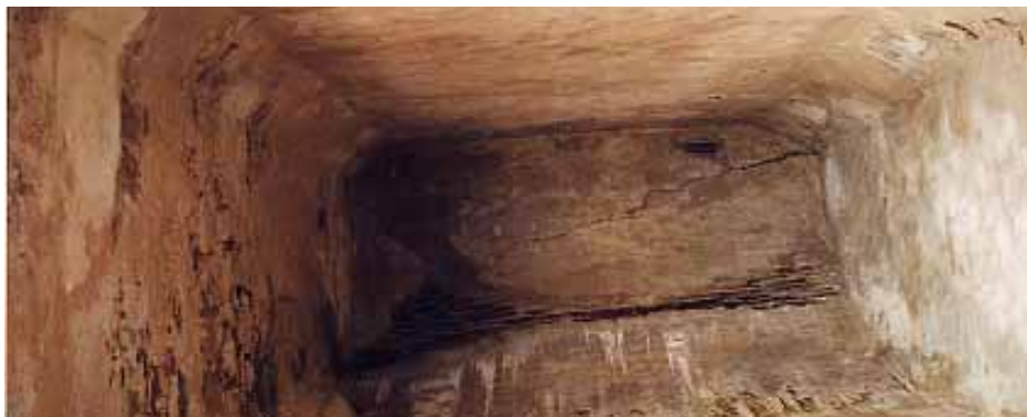
Figura 6.27 - Fendilhação da abóbada botante da 1ª tribuna da galeria Norte.
