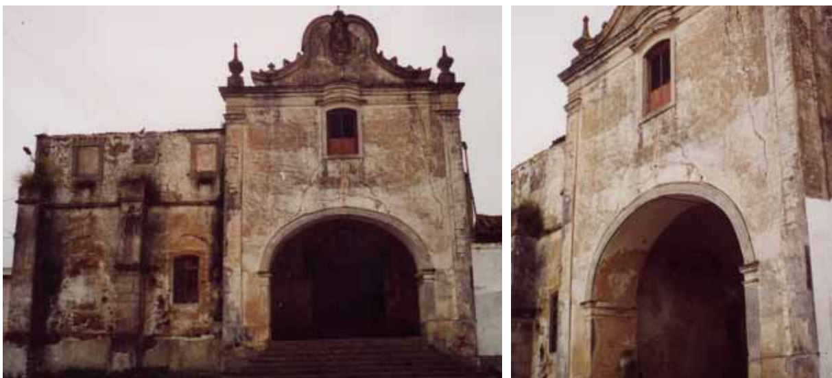
Figura 7.1 - Igreja de São Francisco em Montemor - fendilhação da fachada principal.
