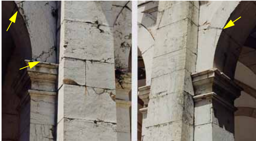
Figura 5.38 - Danos nos arcos das estruturas dos claustros do mosteiro de São Vicente de Fora.
