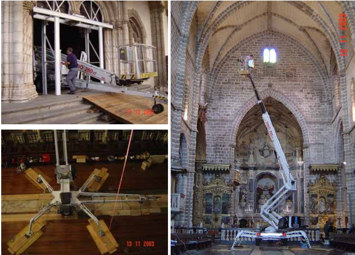
Figura 6.6 - Plataforma elevatória para inspeção e monitorização da abóbada da Igreja de São Francisco.
