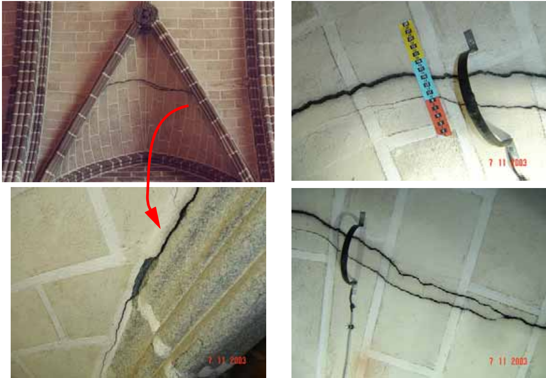
Figura 6.13 - Pormenores da luneta do 2º tramo do lado Sul.
