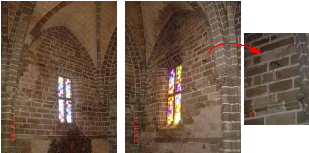
Figura 6.26 - Vista das paredes Norte (esquerda) e Sul (direita) do cruzeiro (7º tramo).
