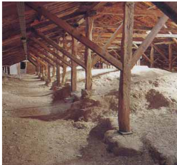
Figura 3.126 - Enchimento do extradorso da abóbada da nave do mosteiro de Alcobaça.
