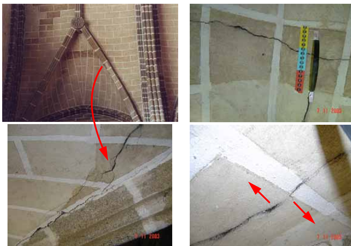
Figura 6.12 - Pormenores da luneta do 1º tramo do lado Norte.
