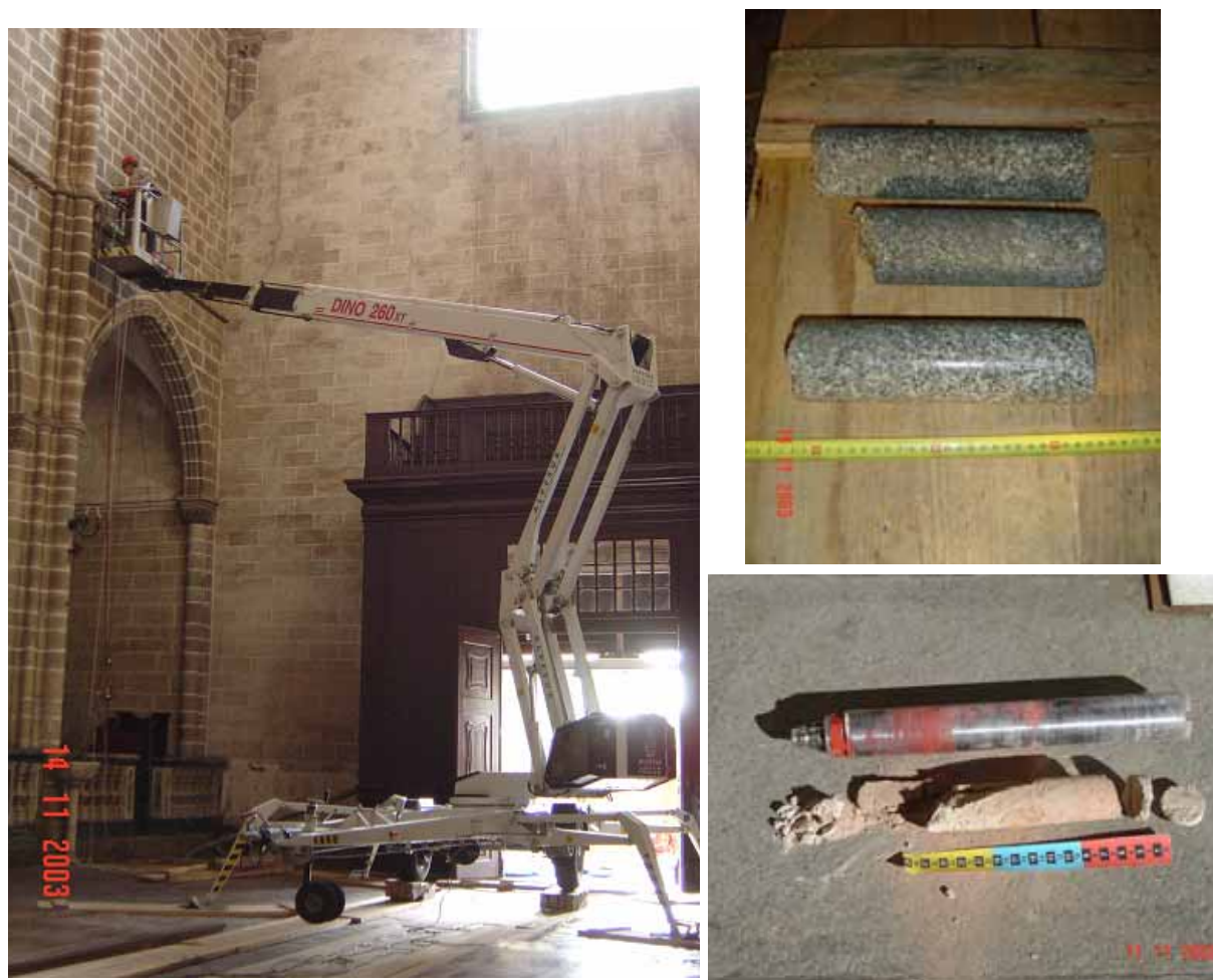
Figura 6.8 - Extração de carotes nas paredes da nave e na abóbada.
