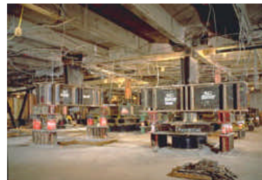
Fase de construção
