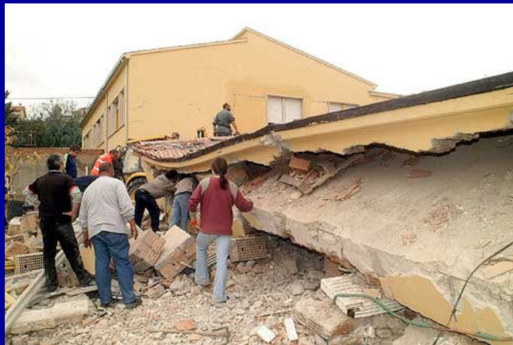
Escola primária de San Giuliano, colapso do edifício. Sismo de Molise (San Giuliano di Puglia, Itália), 31 de Outubro de 2002.
