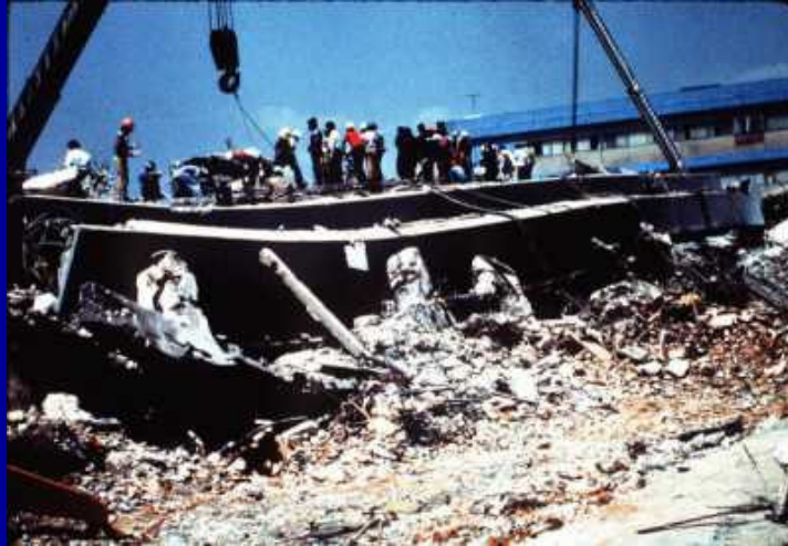
Hospital General, sismo do México, 1985. Colapso total de edifício (295 vítimas mortais).
