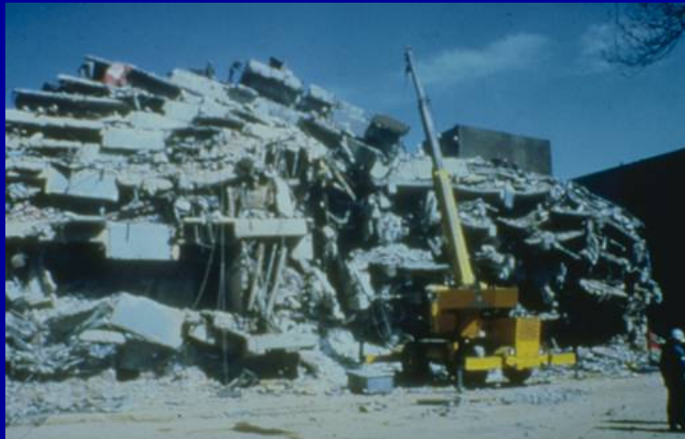
Hospital Benito Juárez, sismo do México, 1985. Colapso total de torre (561 vítimas mortais).
