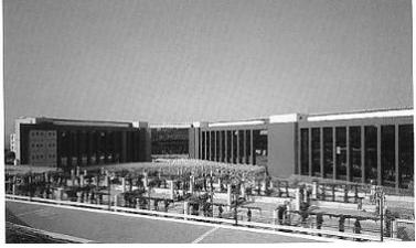
O conjunto é composto por cinco edifícios de 7 pisos. O deslocamento máximo de projecto é de 145mm. Foram utilizados apoios do tipo HDRB.
