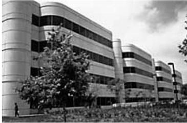
Foi o primeiro edifício com isolamento de base a ser construído nos EEUU e o primeiro no mundo a utilizar HDRB. Está localizado a 20km da falha de S. André.
